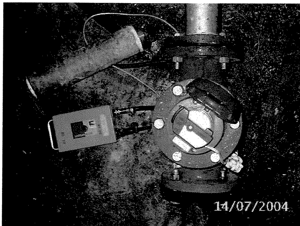
Figura 5.14 – Instalação de coletor de dados no nó N75, entrada do setor Vila Liberdade.
