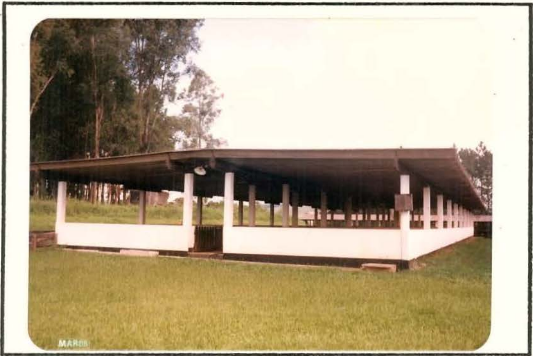
Fig. 21 - Vista parcial da edificação estudada.
