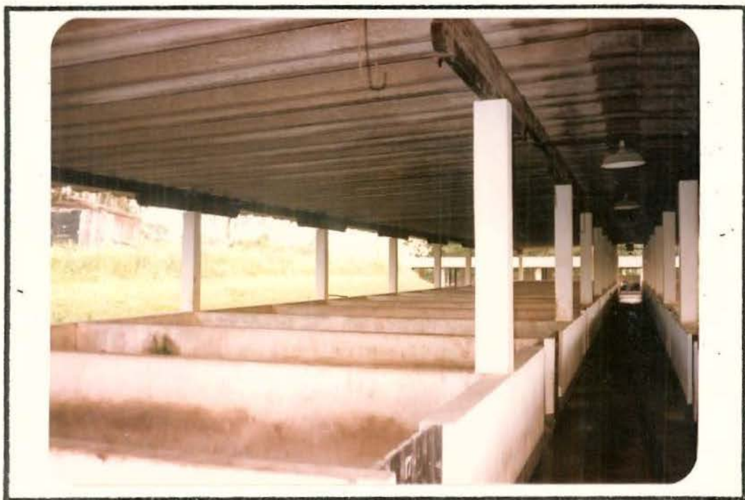
Fig. 58 - Vista interna da edificação estudada.
