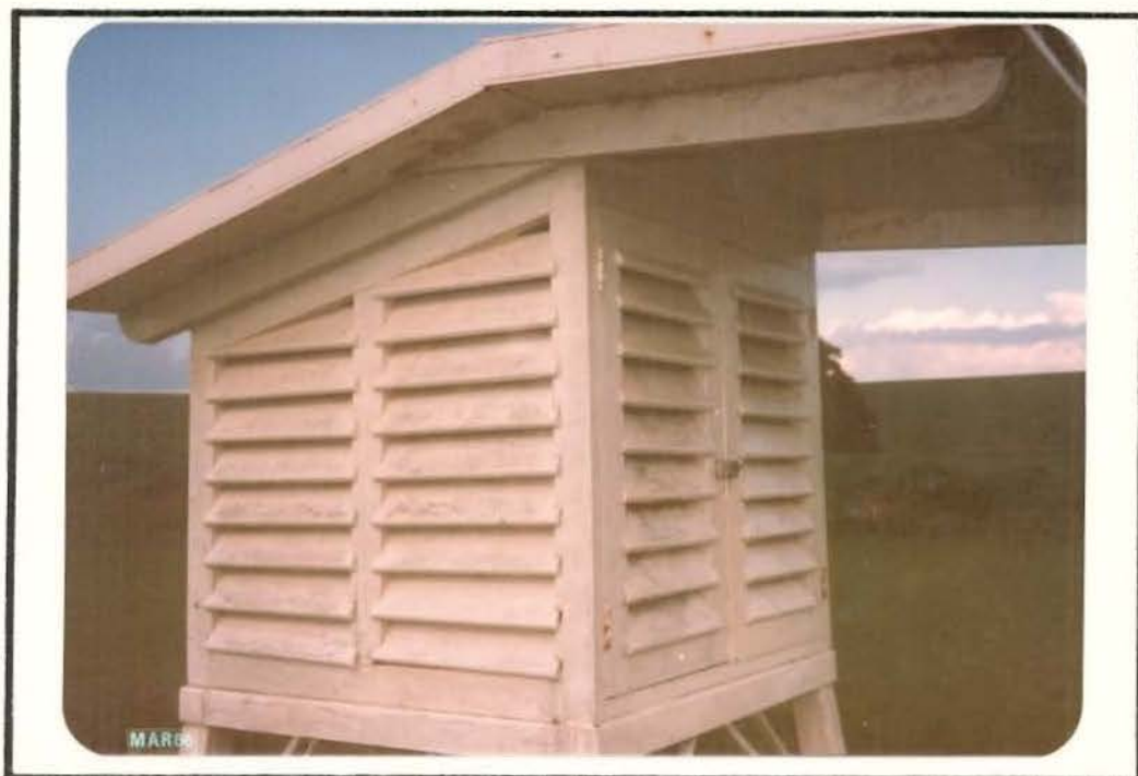
Fig. 23a - Vista da casa de proteção dos termômetros para leitura de temperatura externa.
