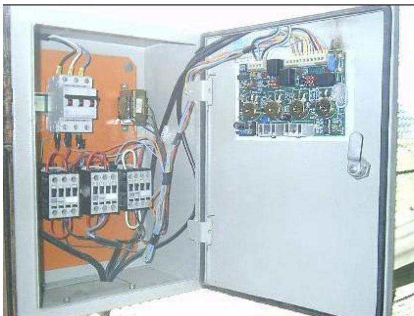
Figura 11 – Quadro de comando automático da bomba e exaustores
