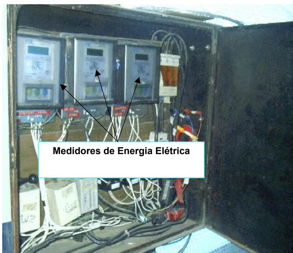
Figura 8 – Medidores SAGA 2300 e transformadores de corrente
