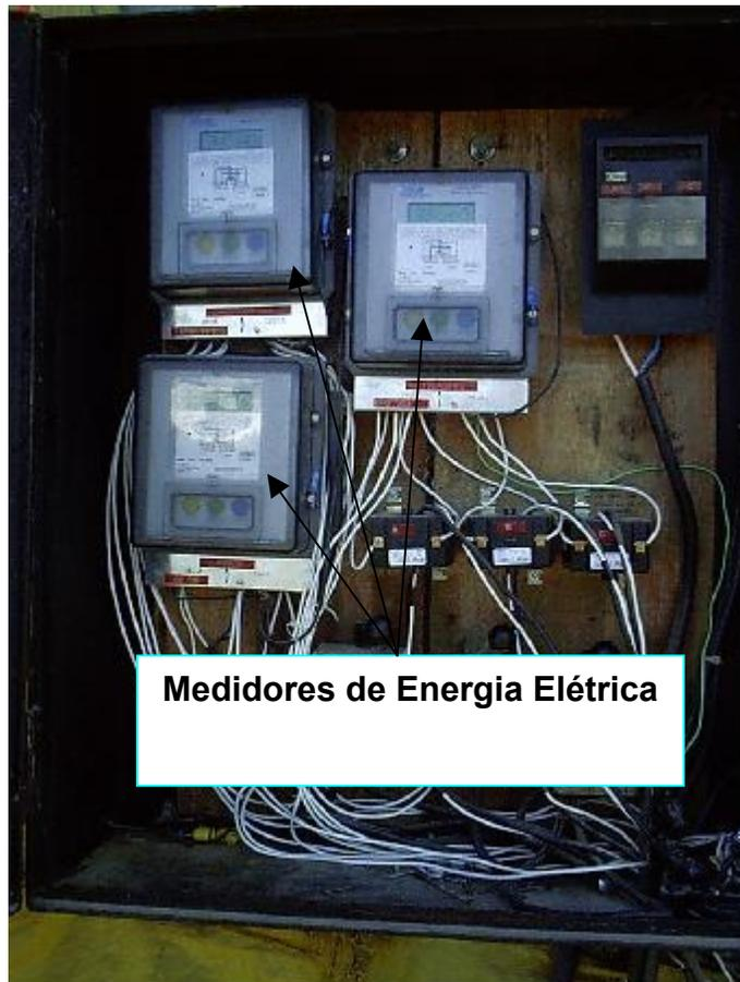
Figura 6 – Quadro dos Medidores de Energia do Galpão 1
