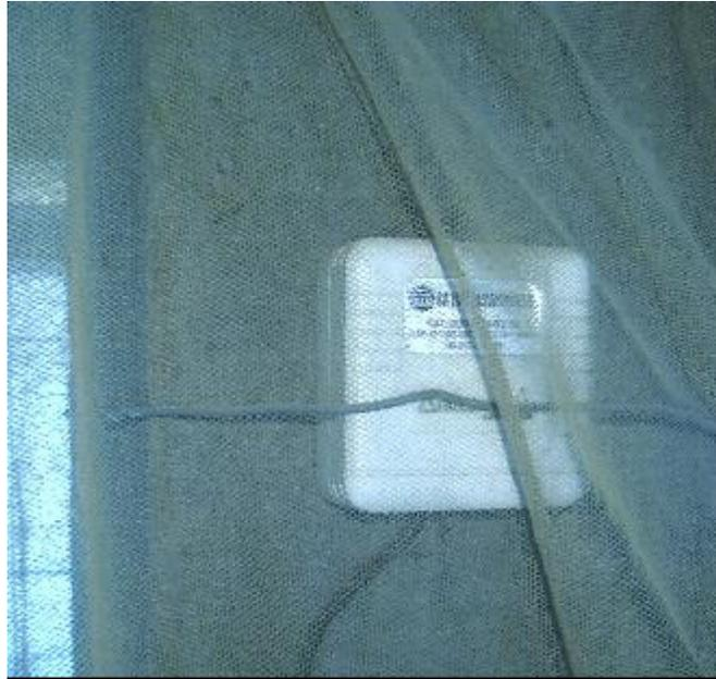
Figura 5 – Transmissor de temperatura e umidade
