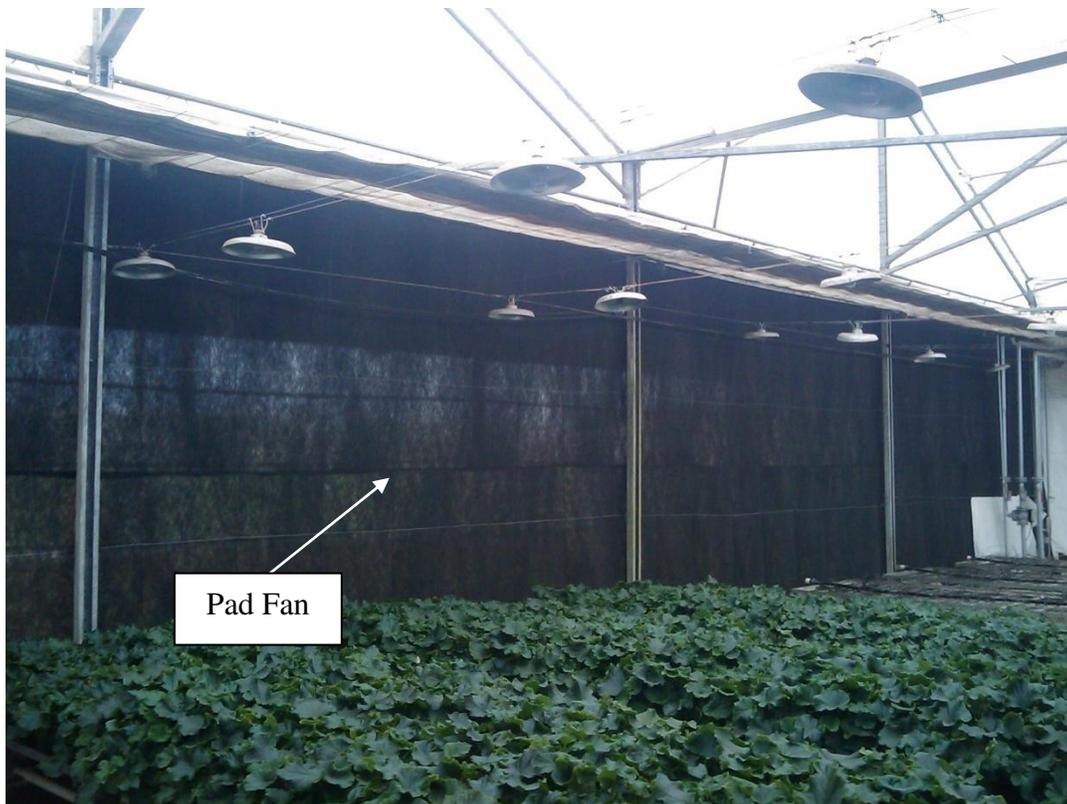
**Figura 13 – Sistema de Resfriamento Evaporativo Adiabático**
