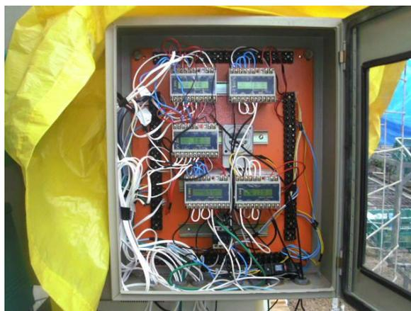
**Figura 27 - Transdutores digitais IMS SmartTrans**
