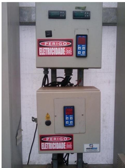
**Figura 11 – Painel de parametrização das variáveis climáticas**
