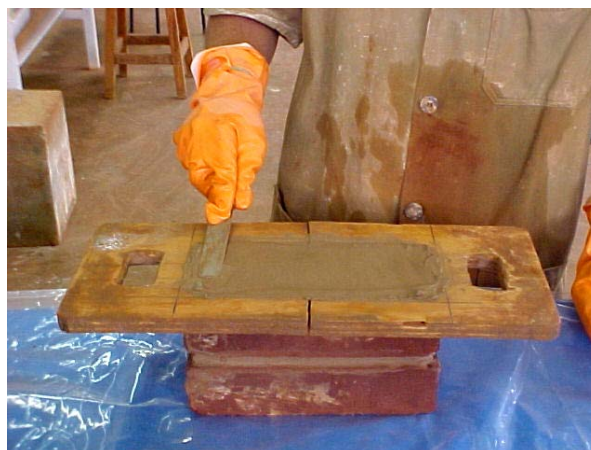
Figura 24. Assentamento dos tijolos.
