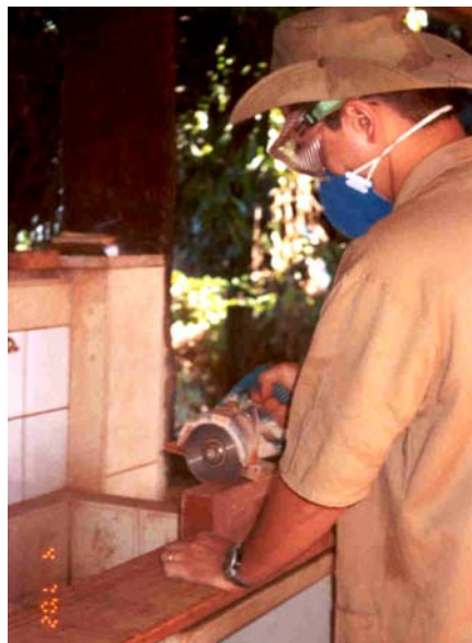
Figura 16. Tijolo sendo serrado ao meio.
