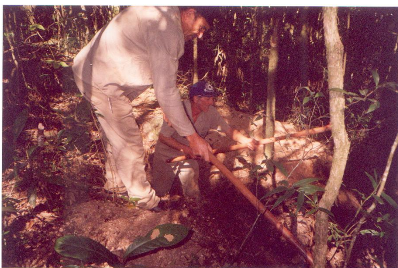
Figura 4 – Abertura de trincheiras na microbacia da Reserva Biológica Municipal da Serra do Japi Jundiá – SP.
