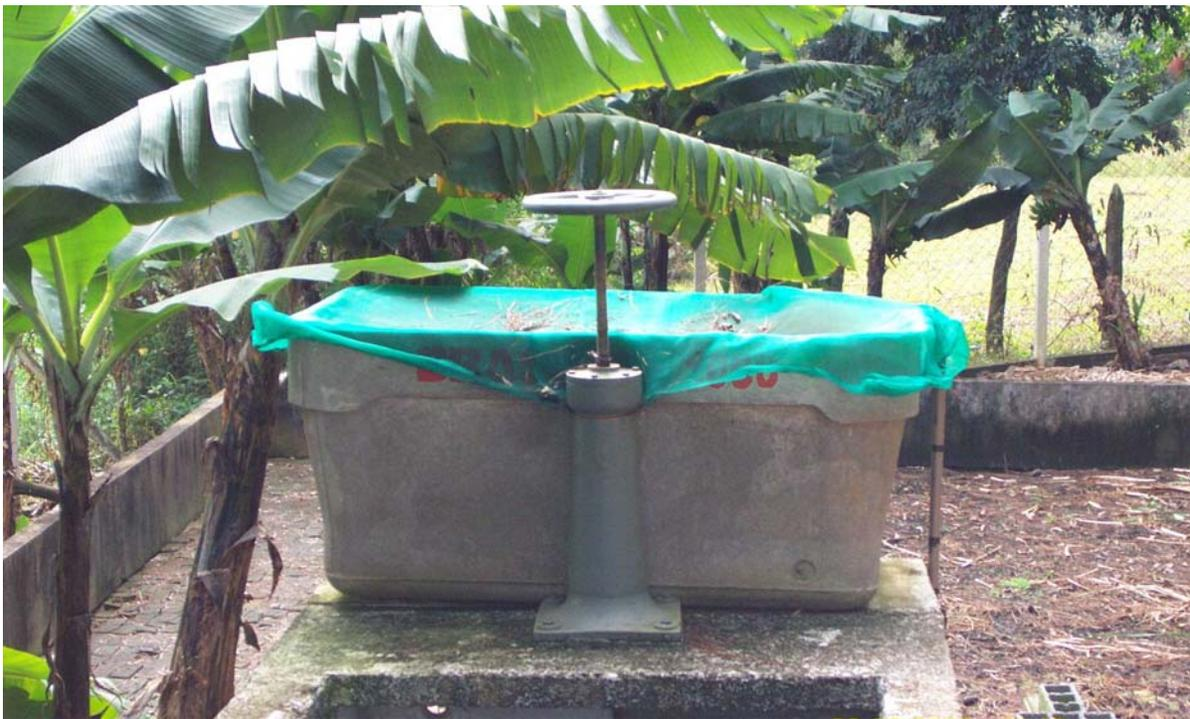
**Figura 5:** Tanque para a Equalização do Afluente dos Leitos Cultivados (COLLAÇO, 2002).
