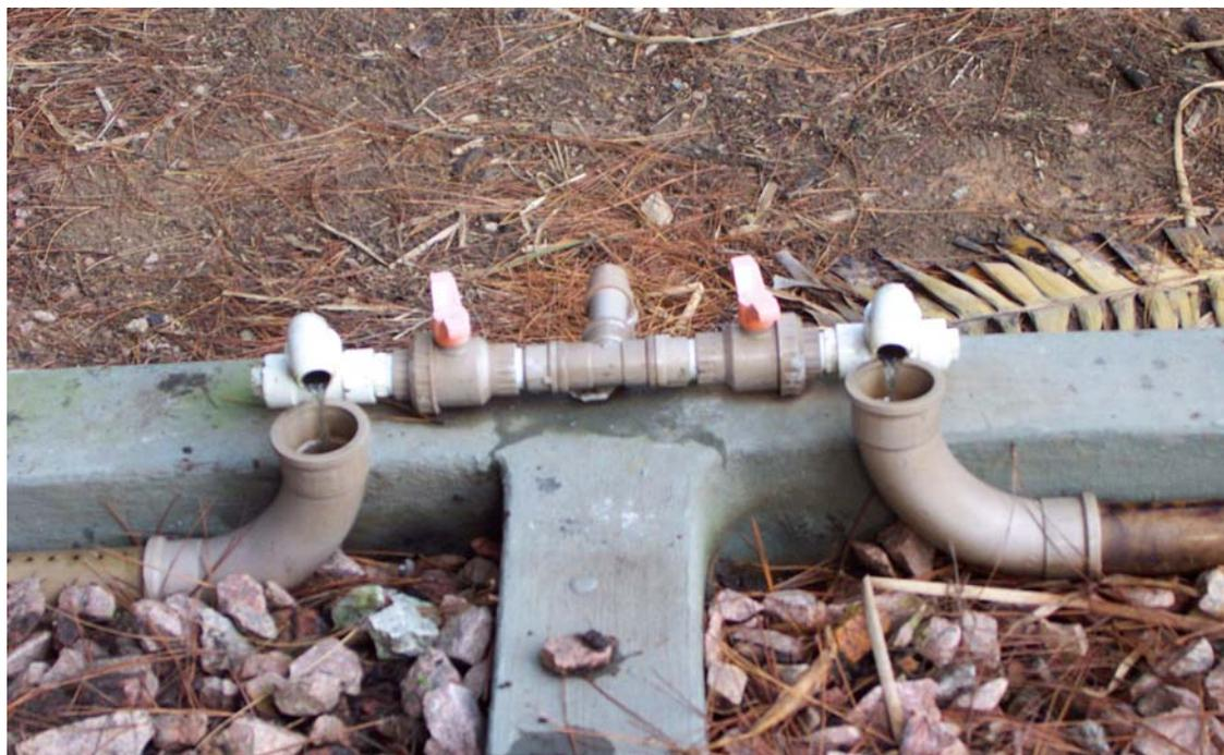
**Figura 6:** Dispositivo para a Distribuição do Afluente nos Leitos Cultivados (COLLAÇO, 2002).
