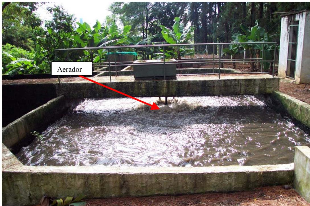
**Figura 2:** Tanque de Aeração da Estação de Tratamento de Esgoto (ETE) do CAPTA –Eng. e Aut.
