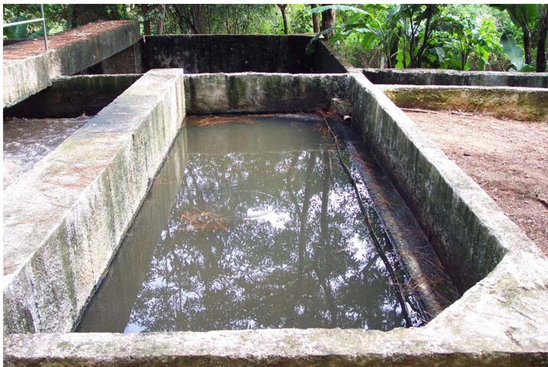
**Figura 3:** Tanque de Sedimentação da Estação de Tratamento de Esgoto (ETE) do CAPTA –Eng. e Aut.
