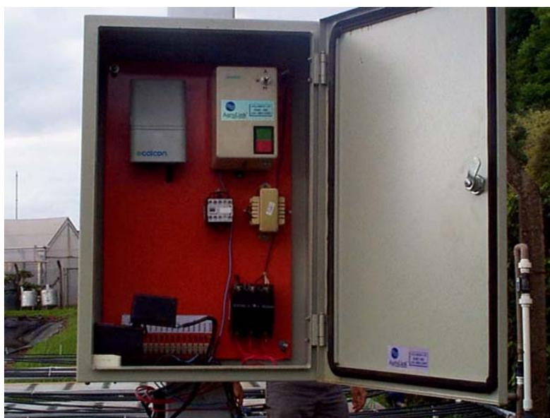
**Figura 10 - Controlador automático de irrigação e contactora**
