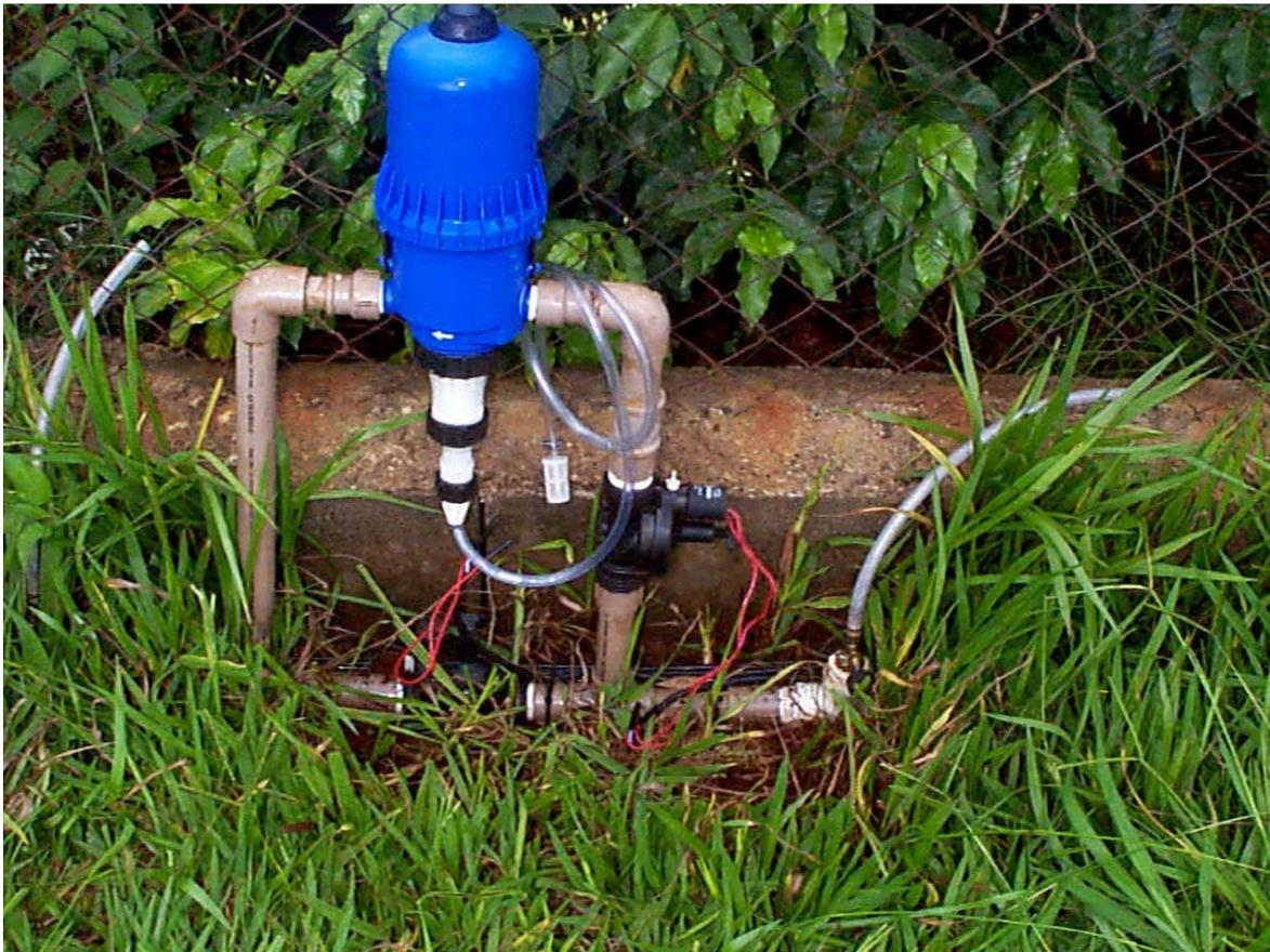
**Figura 13 Bomba injetora de fertilizante da marca DOSATRON**
