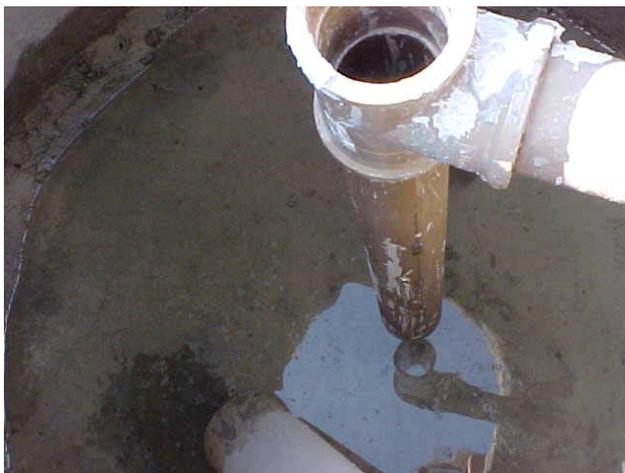
*Figura 13. Detalhe do sistema de entrada de efluente, interior do RAC.*
