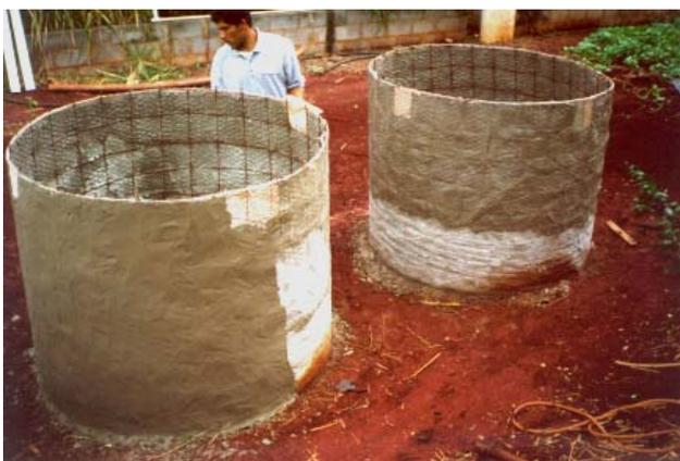
*Figura 15. Aplicação da argamassa de revestimento do leitões.*
