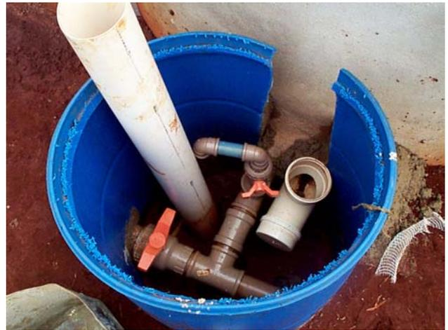
*Figura 18. Vista das tubulações: drenagem, coleta de amostras e inspeção de nível.*
