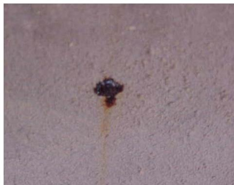
*Figura 26. Vista da região interna que apresentou oxidação da malha de ferro.*
