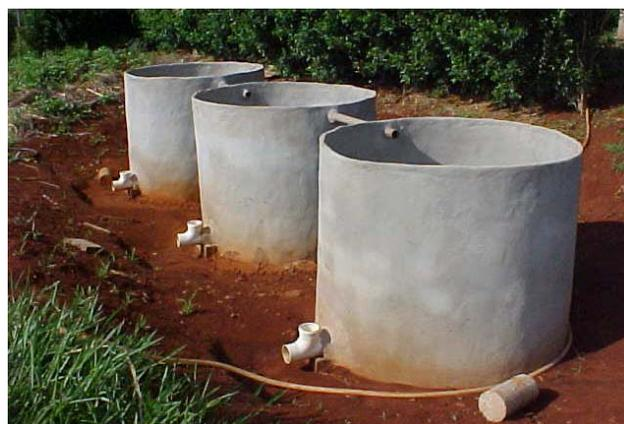
*Figura 16. Vista geral da estrutura dos três leitões cultivados, após o revestimento.*
