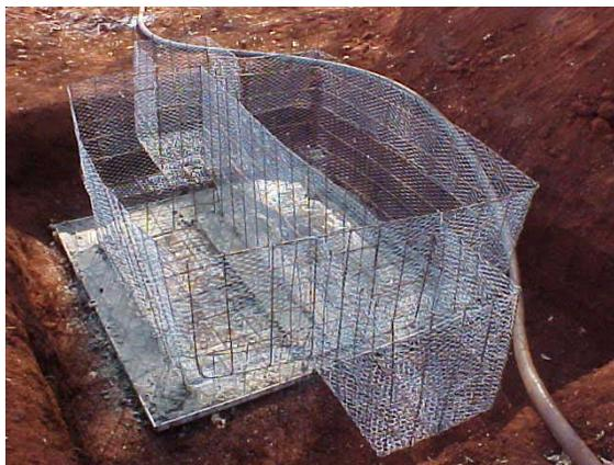
*Figura 8. Vista geral do aramado fixado na base de concreto*
