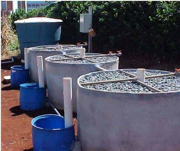
Figura 19. Vista dos leitos preenchidos com brita, com os sistemas de distribuição, reservatório e controlador eletrônico.
