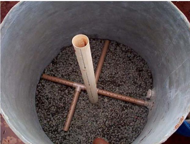
*Figura 17. Vista da tubulação de drenagem e inspeção dos leitos.*
