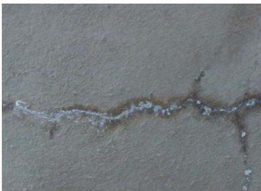
*Figura 25. Vista da região externa que apresentou infiltração*
