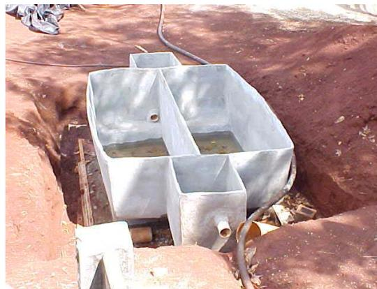
*Figura 9. Vista geral da estrutura revestida com a argamassa.*
