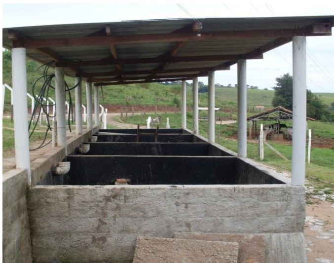
Figura 24 - Vista superior das quatro paredes divisórias das caixas de retenção.
