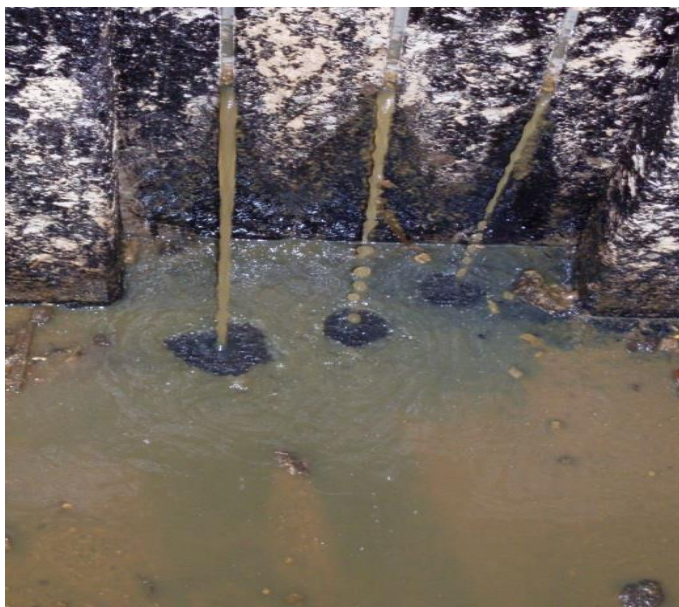
Figura 27 - Processo de drenagem da fração líquida do efluente armazenado nas caixas de retenção.
