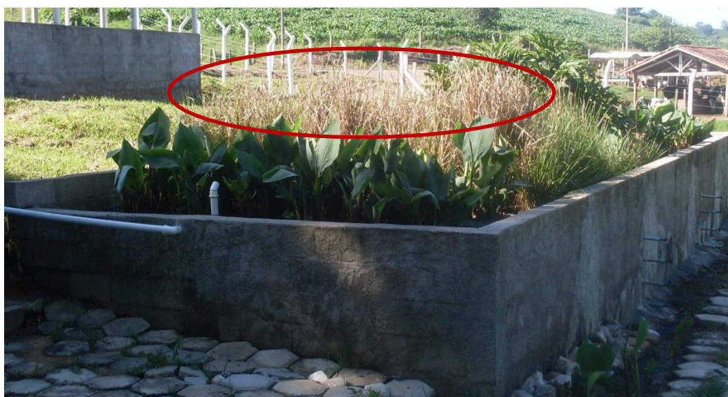
Figura 55 - Wetland construído com destaque para as folhas secas do capim vetiver
