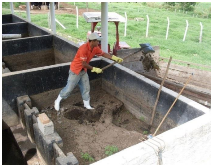
Figura 30 - Retirada manual dos sólidos desidratados das caixas de retenção.
