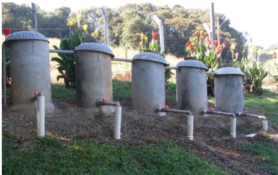
Figura 37 - Sequência de cinco caixas para separação dos sólidos.
