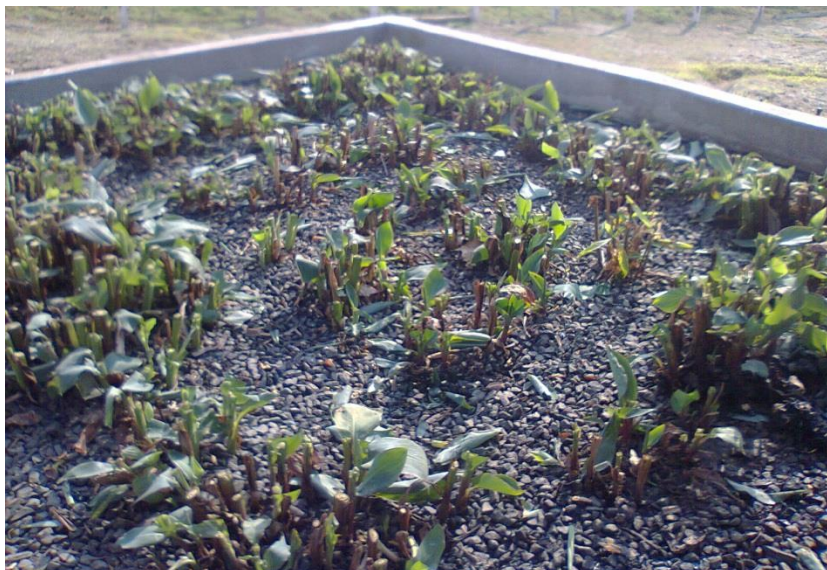
Figura 56 - Destaque para as áreas sem vegetação de plantas no wetland construído.
