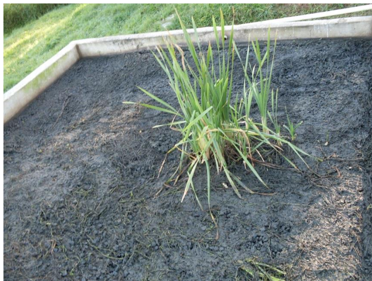
Figura 54 – Presença de matéria orgânica sobre o meio suporte do wetland.
