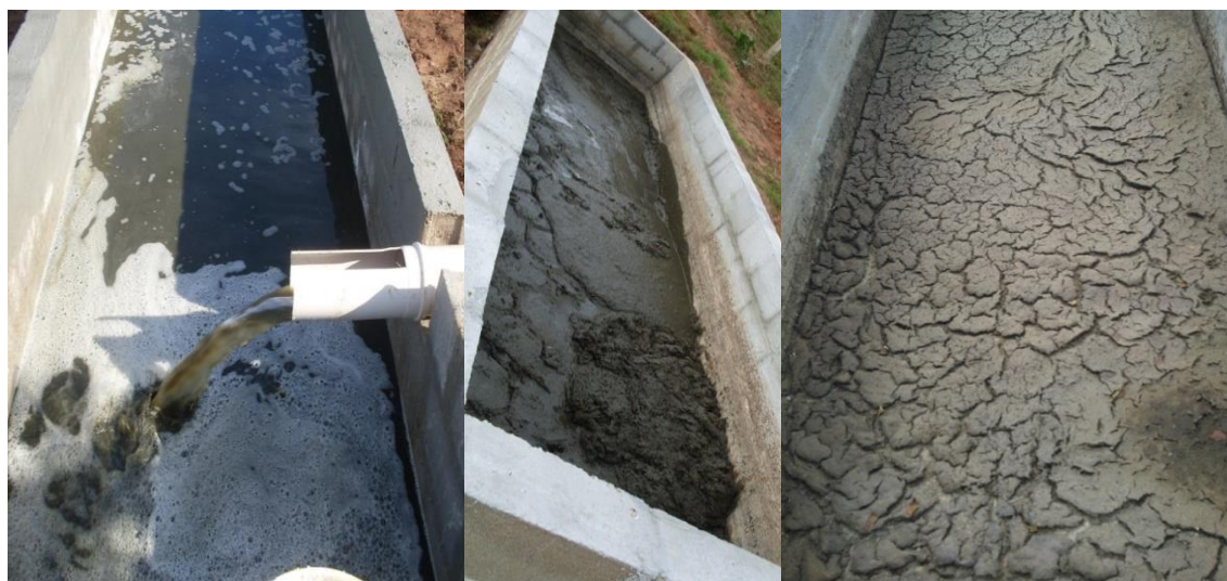
Figura 50 - Lançamento e processo de desidratação do lodo bruto.
