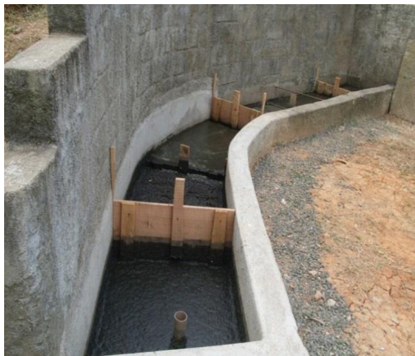
Figura 32 - Canal de decantação destaque para os stop logs.
