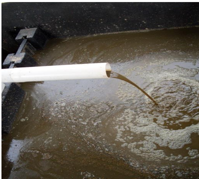
Figura 26 - Aparência dos resíduos líquidos lançados nas caixas de retenção.
