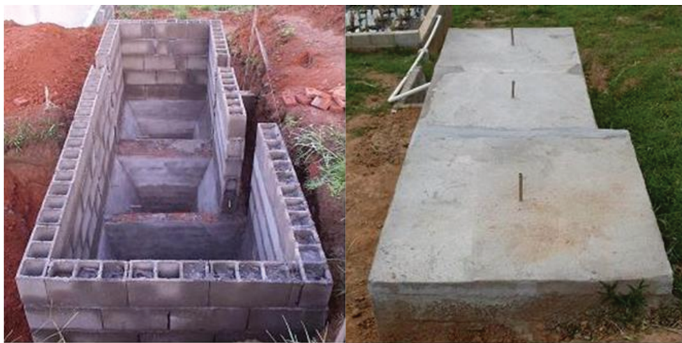
Figura 43 - RAC em construção e lacrado com as placas de concreto.
