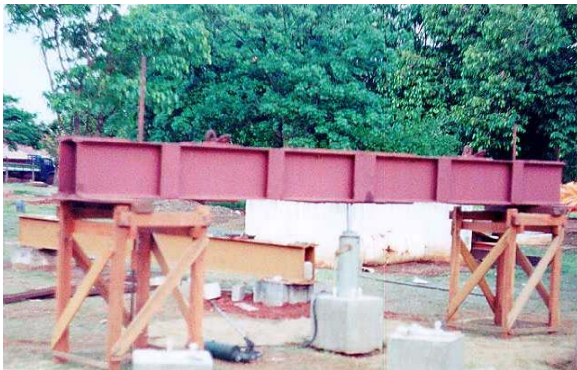
Figura 4.7 – Vigas de reação
