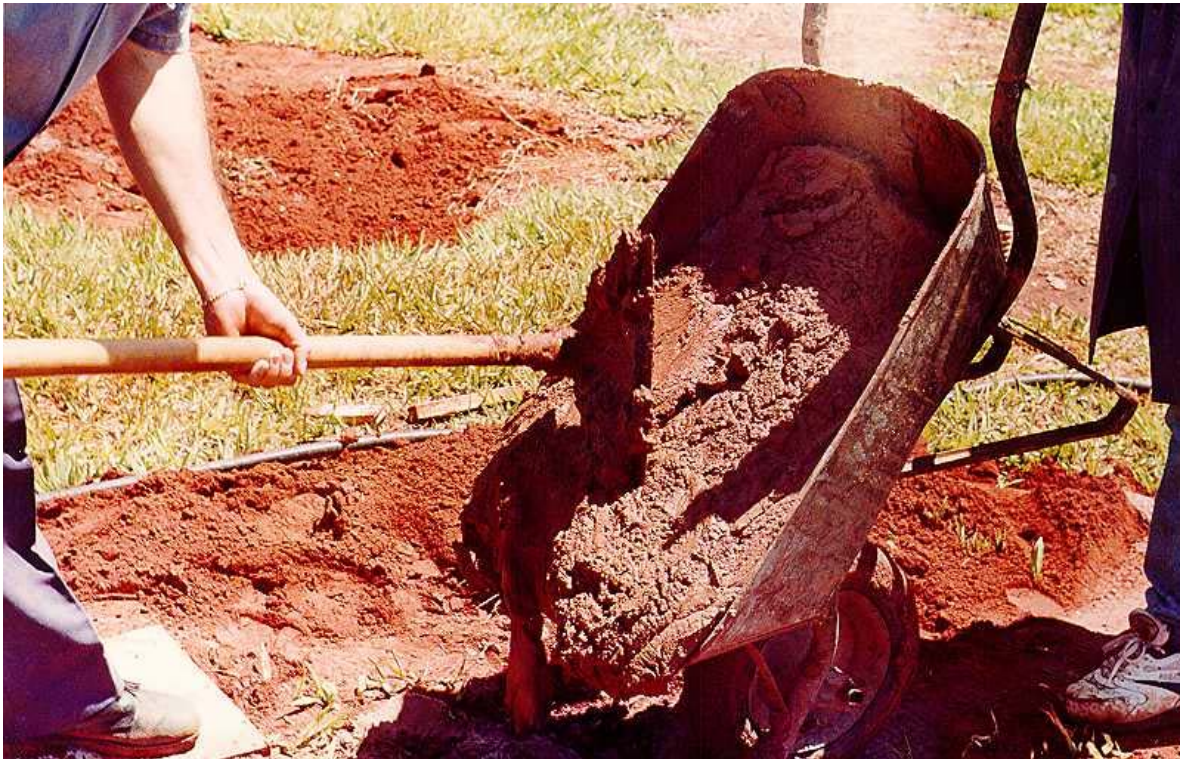
Figura 4.4 – Aplicação do SCP no furo das estacas
