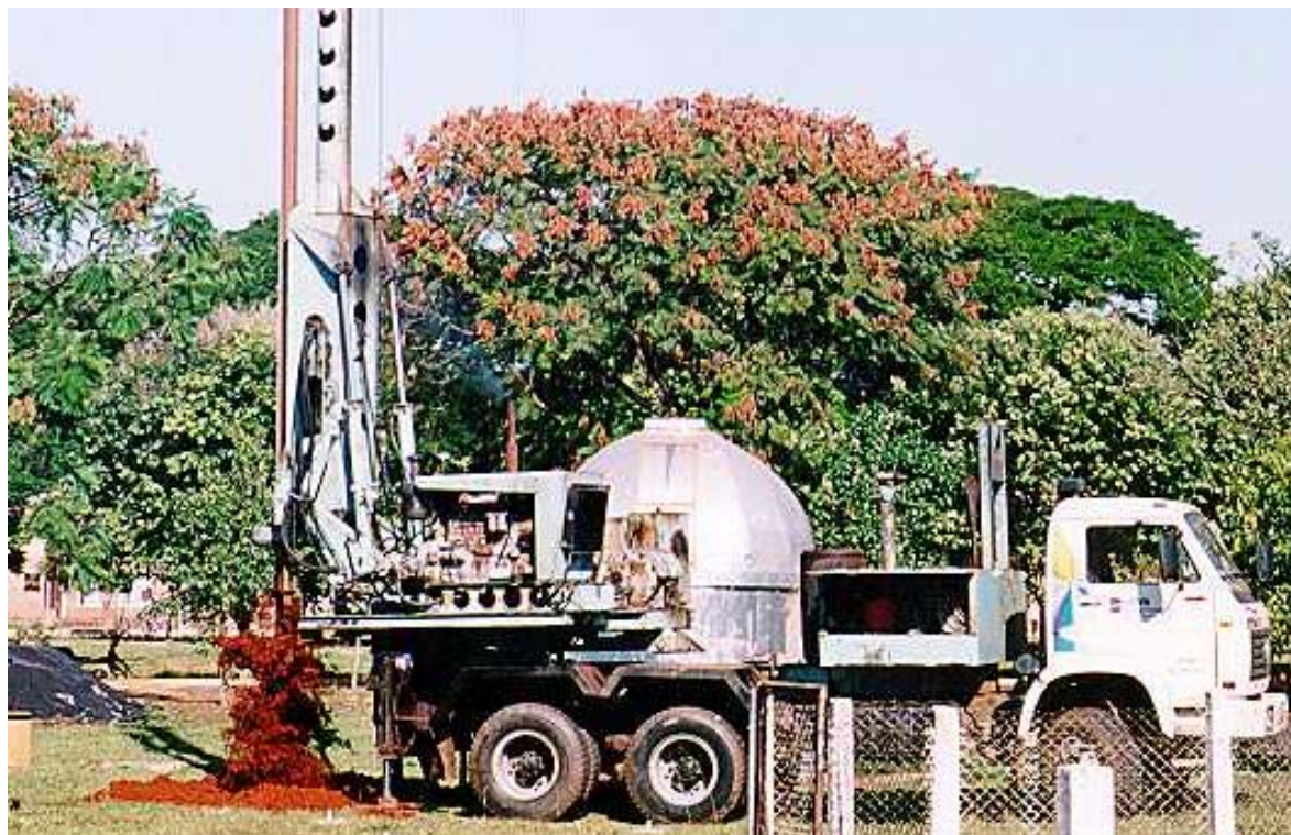
Figura 4.10 – Equipamento utilizado na confecção das estacas escavadas
