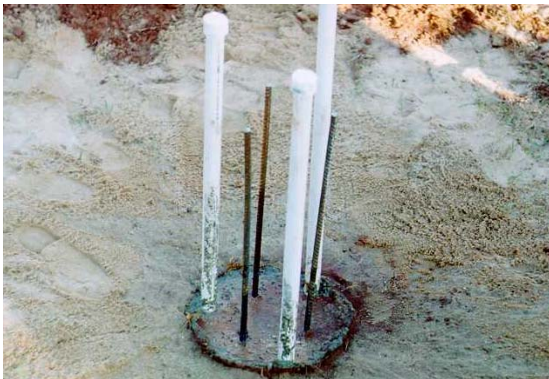
Figura 4.11 – Estaca pronta para receber o bloco de transição
