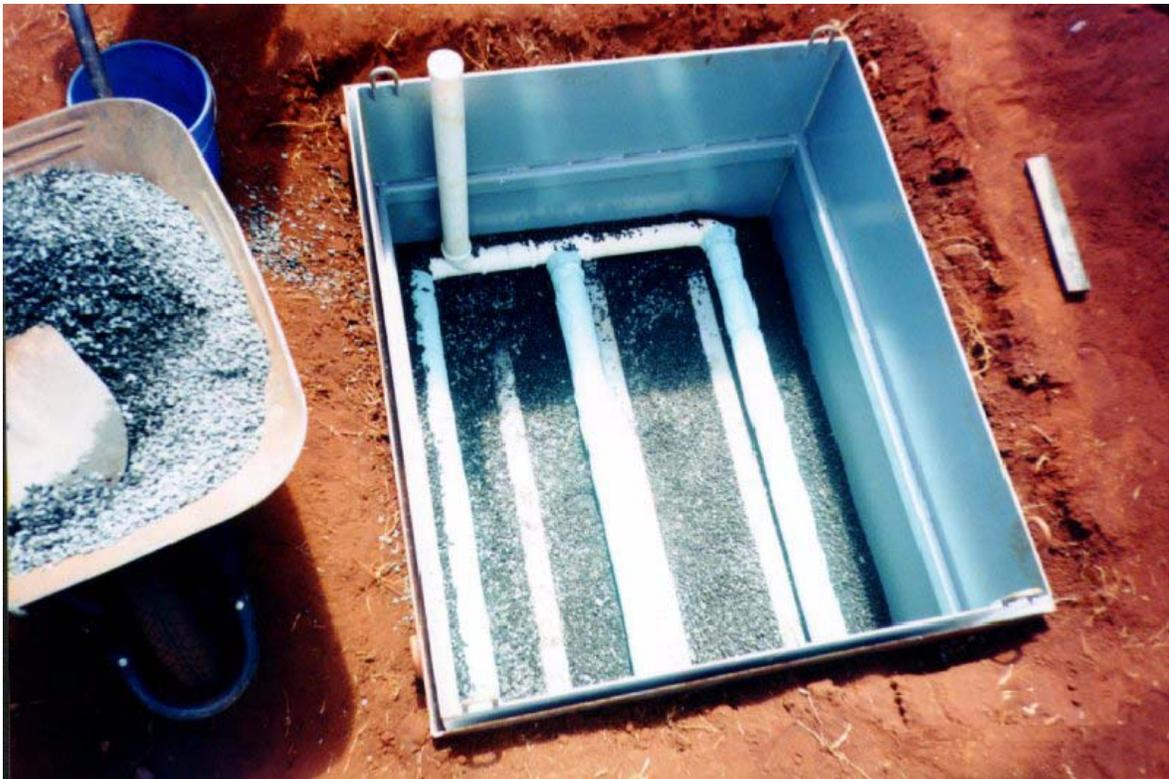
FIGURA 3: Sistema de drenagem instalado no fundo dos tanques internos
