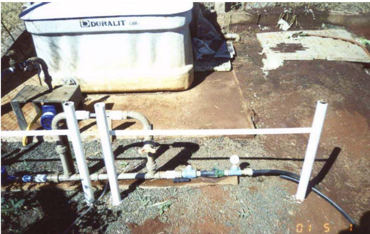
FIGURA 8: Válvula reguladora de pressão (14 mca) e manômetro na saída do cabeçal de controle.
