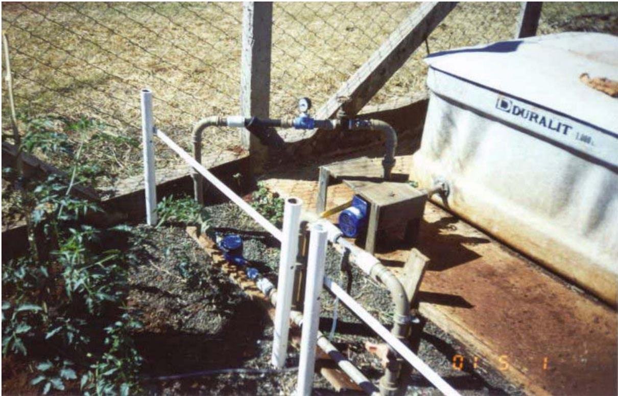
FIGURA 7: Cabeçal de controle do sistema de irrigação.
