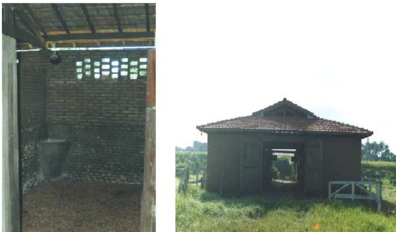
Figura 4. Vista interna da coqueira padrão e vista externa das coqueiras do local.
