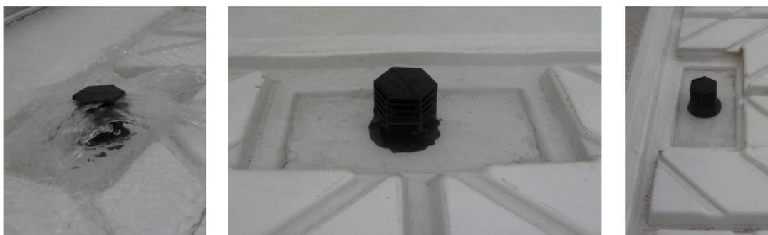
**Figura 25. Vista do detalhe do orifício de adução e drenagem da mesa de subirrigação, do rebaixamento das canaletas e a válvula defletora.**
