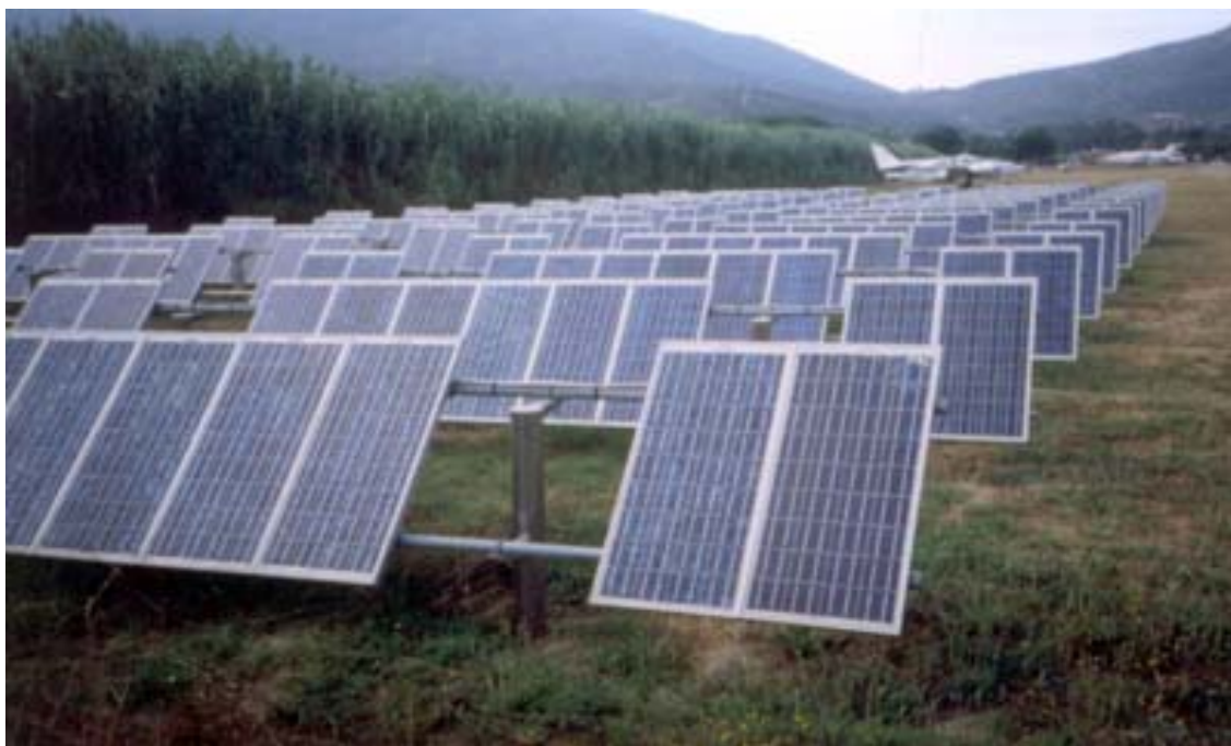
Figura 3. Sistema fotovoltaico centralizado para fornecimento de eletricidade a um pequeno aeroporto e a uma agrovila no sul da Itália.
