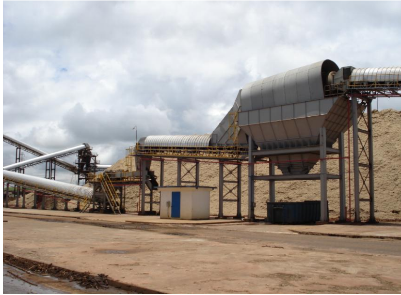
Figura 19: Peneira para retirada de impurezas minerais contidas na palha – Usina Equipav.
