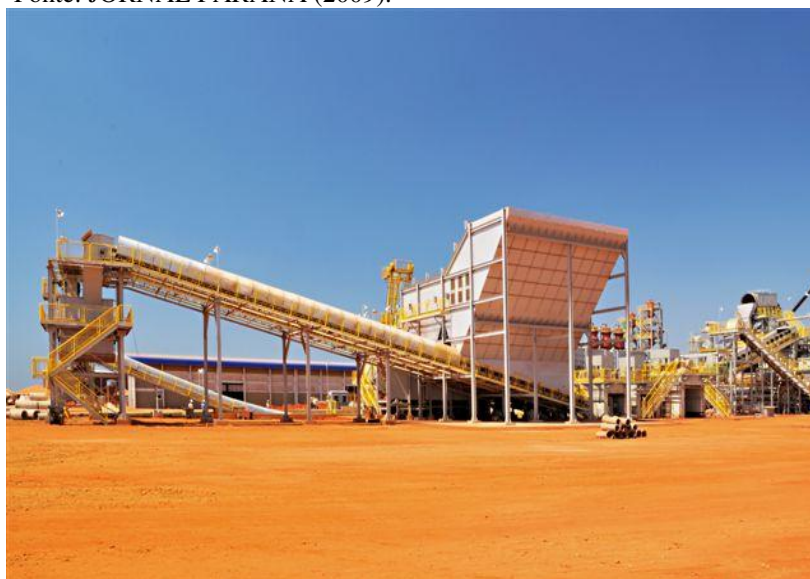
Figura 13: Sistema de Limpeza – Usina Pedro Afonso.
