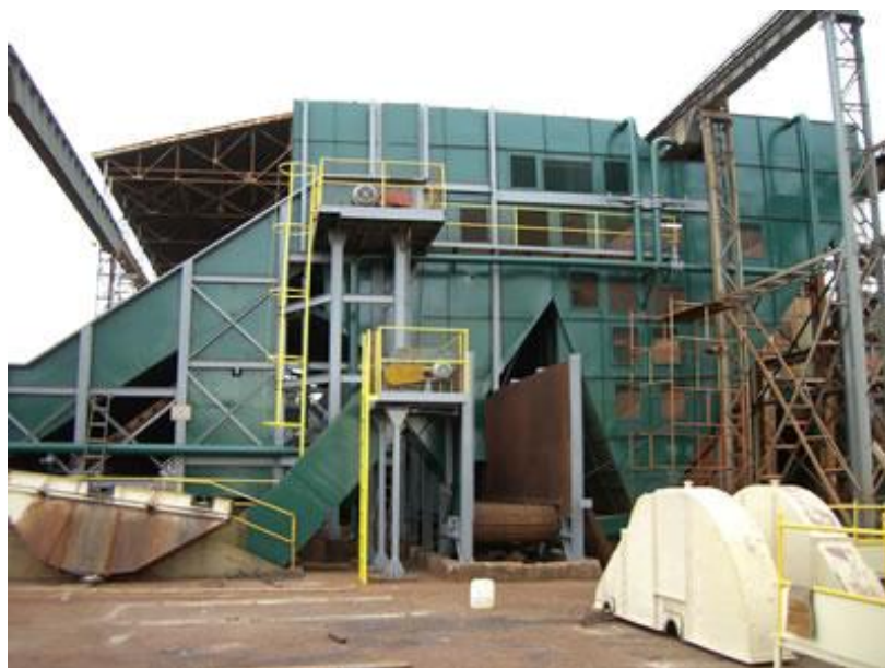
Figura 12: Sistema de Limpeza – Usina Guaíra.
