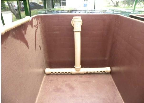
**Figura 02** – Sistema de drenagem com tubos de PVC após a filtragem.
