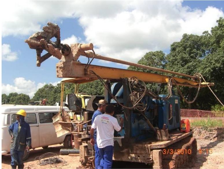
**Figura 2.5.** Equipamento utilizado para execução de colunas de DSM
