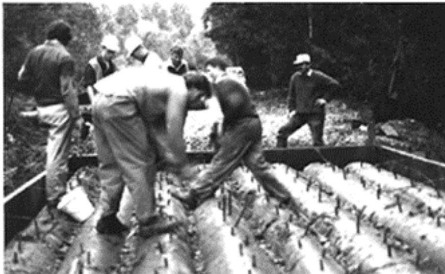
FIGURA 2.03 – Construção de Ponte em concreto-madeira na Austrália.
