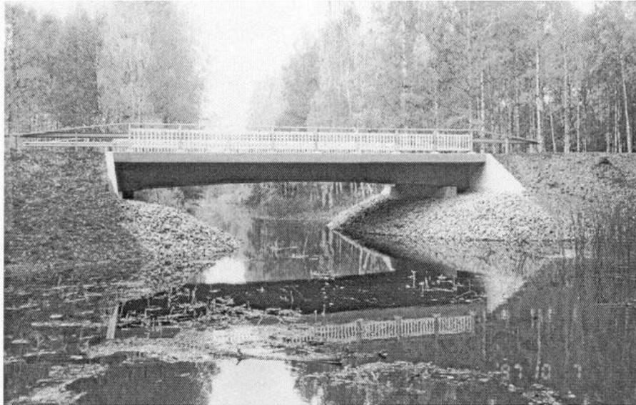
FIGURA 2.05 – Ponte em concreto-madeira na Finlândia.
