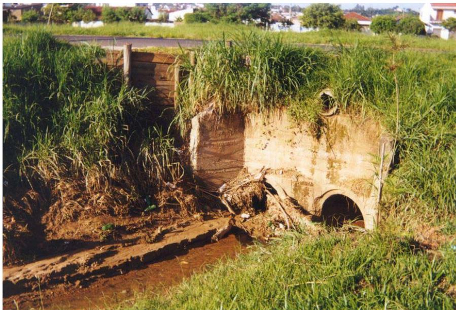
FIGURA 1.04 – Deposição de lixo e redução da seção do tubo de concreto
