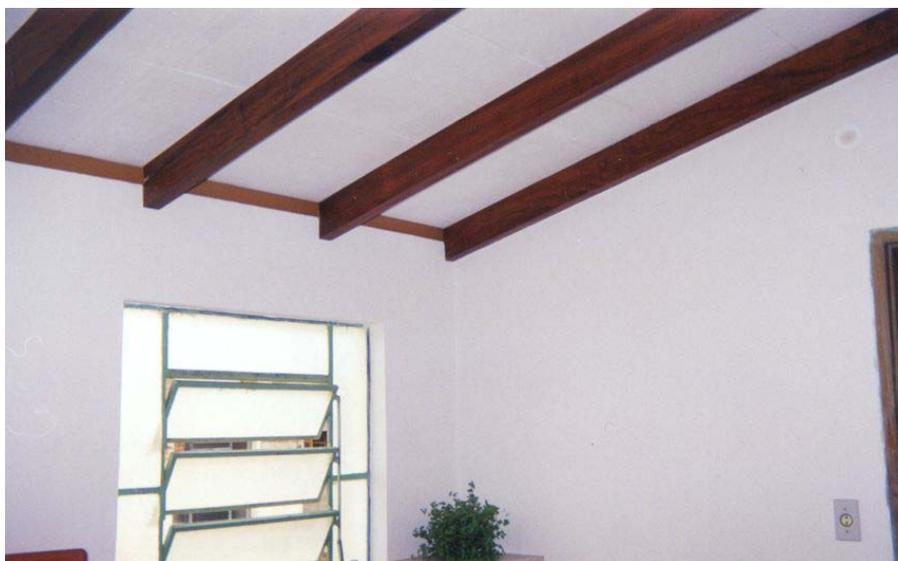
FIGURA 1.10 – Vista de teto em madeira e placas de micro-concreto
