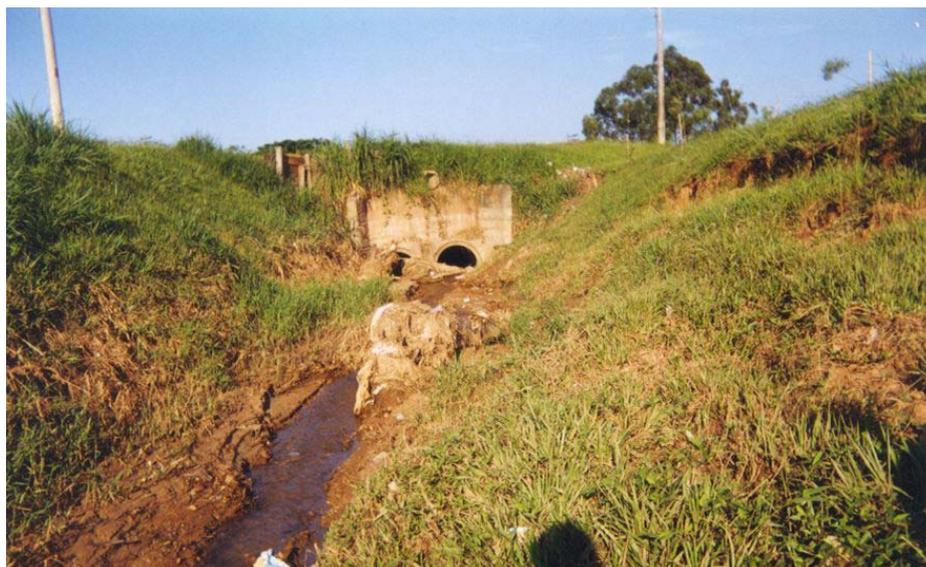
FIGURA 1.05 – Deslizamento da vegetação de proteção do talude
