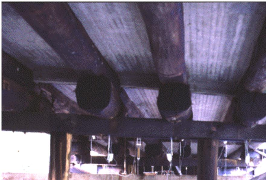
FIGURA 2.04 – Vista inferior de ponte em concreto-madeira na Austrália.
