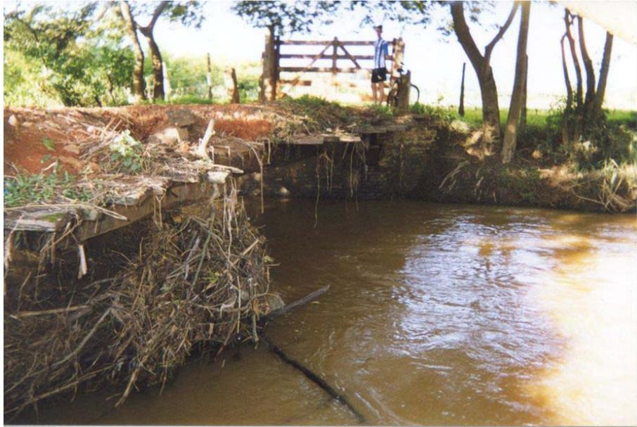
FIGURA 1.08 - Ponte em madeira com camada de solo sobre o tabuleiro
