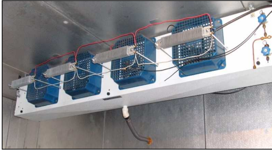
Figura 14. Esquema de posicionamento das resistências e o dreno de água para o Sistema de secagem a quente.
