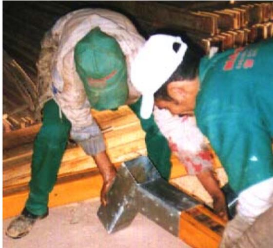
Figura 123 Detalhe da colocação da peça de encaixe entre um pilar e uma viga.
