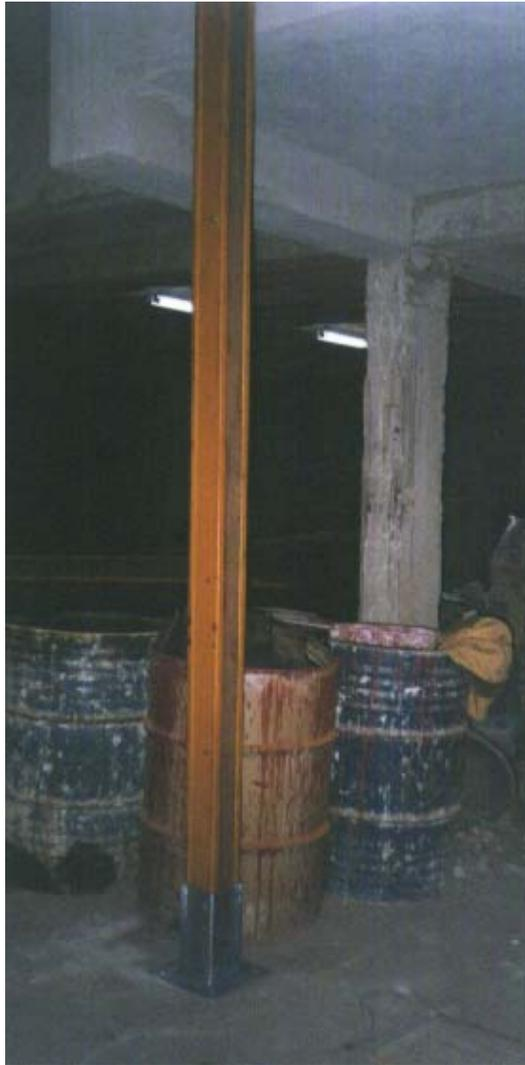
Figura 124 Detalhe de um pilar do pórtico após a montagem.
