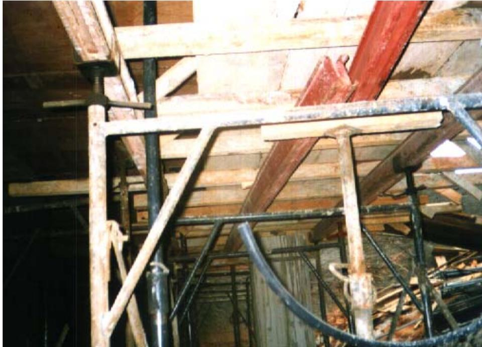
Figura 11 Foto das vigas mistas em início de colapso.
