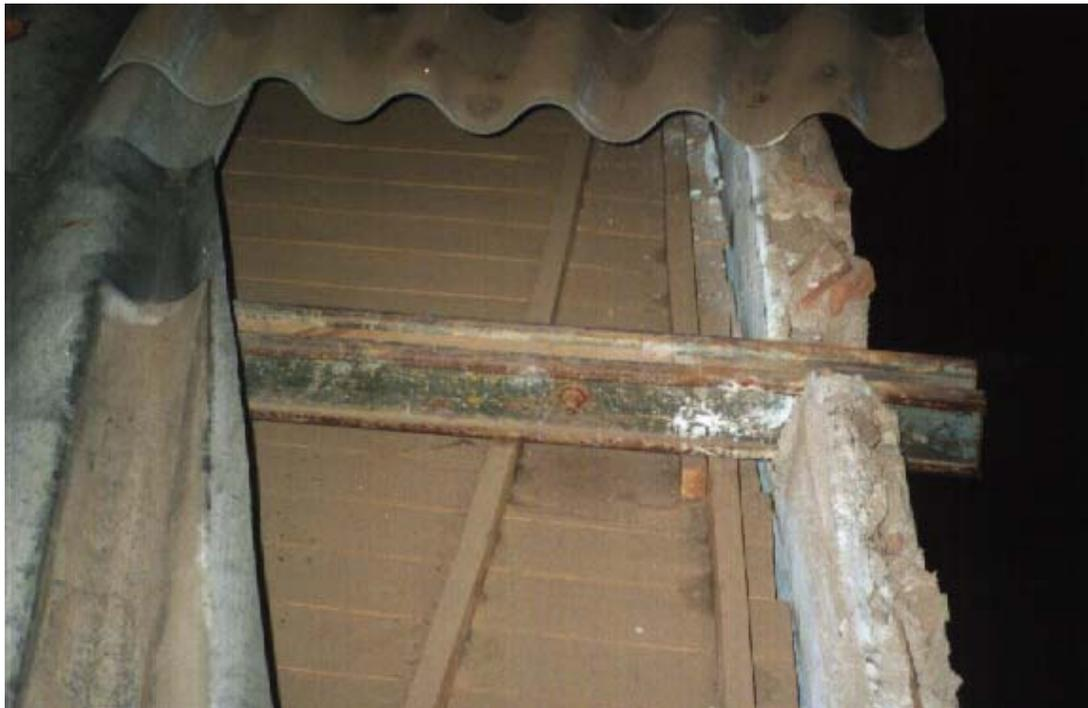
Figura 96 Inspeção das vigas mistas aplicadas em cobertura após 7 anos.
