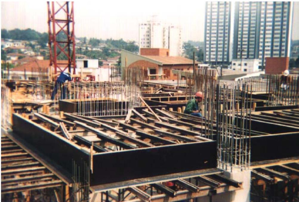
Figura 03 Vigas mistas servindo de apoio para fôrmas de lajes e vigas
