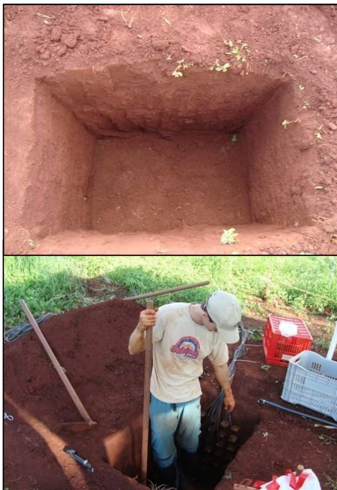
Figura 8. Abertura das trincheiras e instalação das sondas
