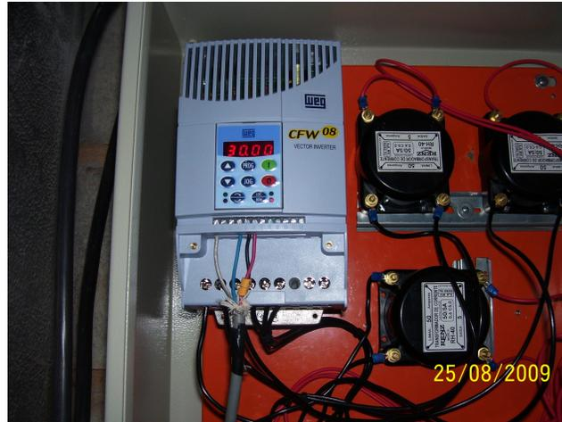
Figura 21: Inversor de frequência
