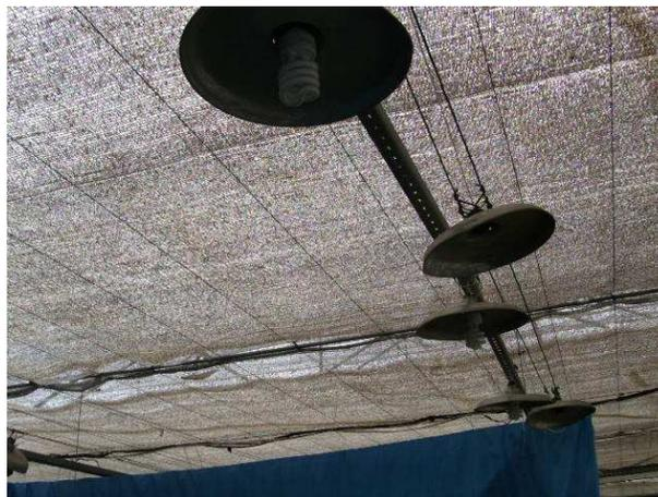
**Figura 6 - Vista da altura de instalação da tecnologia Fluorescente Compacta Integrada de 20 W na cultura de begônias.**
