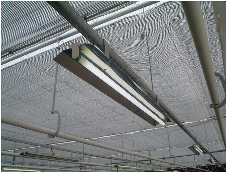
Figura 46 - Foto da luminária tipo calha em aço inox.
