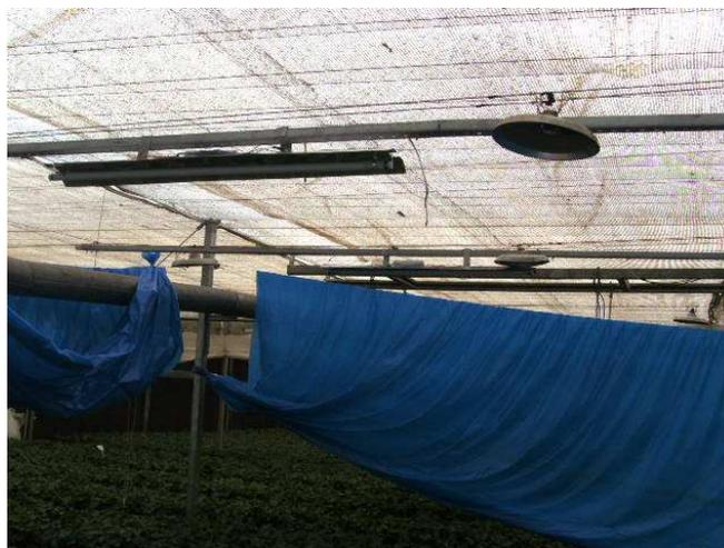
**Figura 7 - Vista da altura de instalação da tecnologia Fluorescente Tubular de 32 W na cultura de begônias.**
