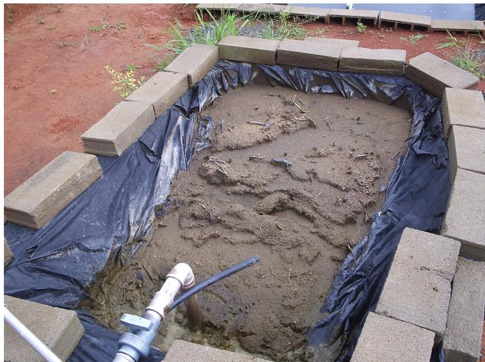
Figura 22 – Aspecto da lagoa anaeróbia no 194º dia de funcionamento da ETE piloto
