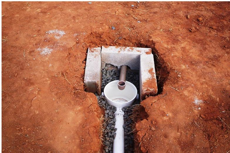
Figura12 – Local de instalação e detalhe do posicionamento da caixa de gordura.
