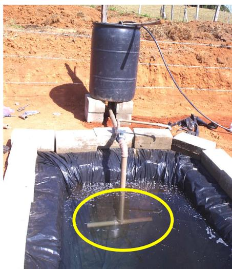
Figura 8 – Formato do encanamento e o local de lançamento do efluente na lagoa anaeróbia.
