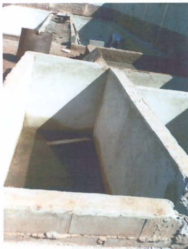
Figura 49 Construção do Tanque Equalizador ou Pulmão
