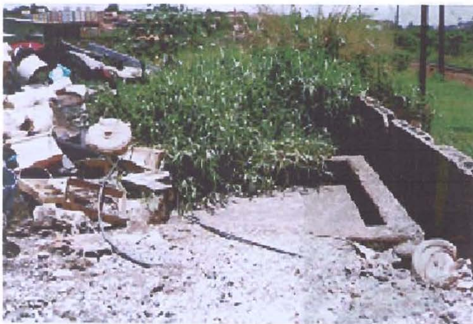
Figura 38 Tanque de sedimentação antes do lançamento final do efluente (segundo tanque) tendo ao redor resíduos da sedimentação para secagem, plásticos recicláveis e vegetação
