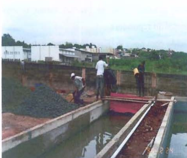
Figura 58 Preenchimento dos leitos com brita
