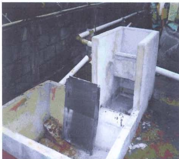
Figura 45 Estrutura de alvenaria da peneira estática (construção)
