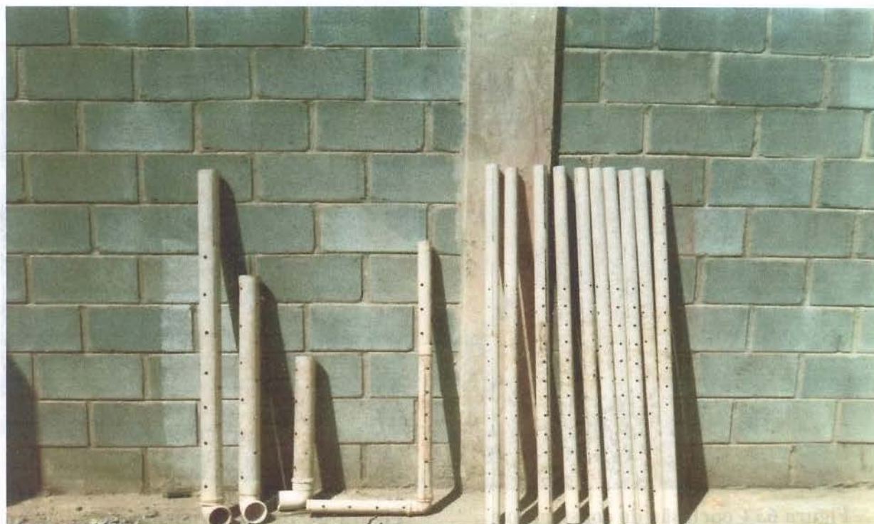
Figura 60 Tubulações de PVC perfuradas utilizadas nos leitos cultivados
