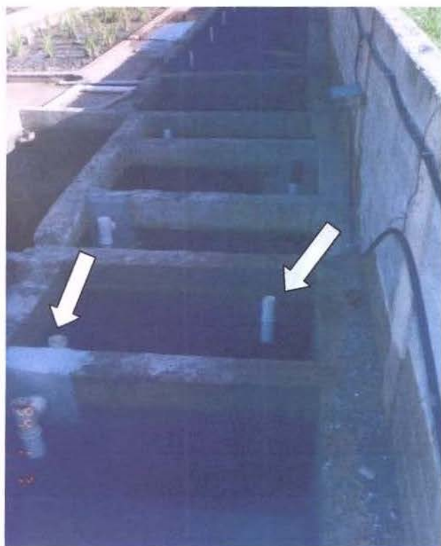
Figura 54 Conclusão da construção do RAC com 6 compartimentos mostrando em detalhe a tubulação de entrada e de saída do efluente em lados opostos nos compartimentos
