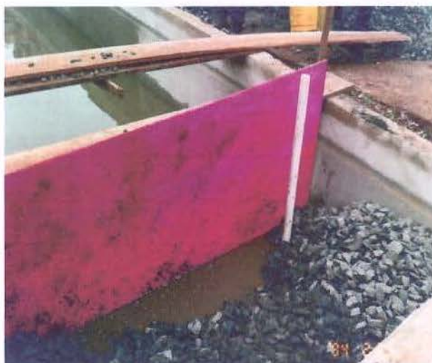
Figura 59 Separação entre brita nº 2 e 3 e colocação de tubulação perfurada para amostragens
