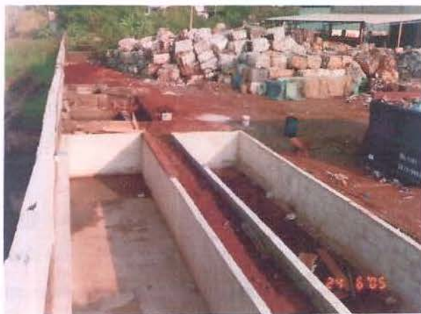
Figura 56 Início da construção dos leitos
