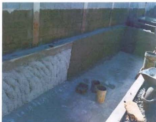
Figura 57 Impermeabilização dos leitos
