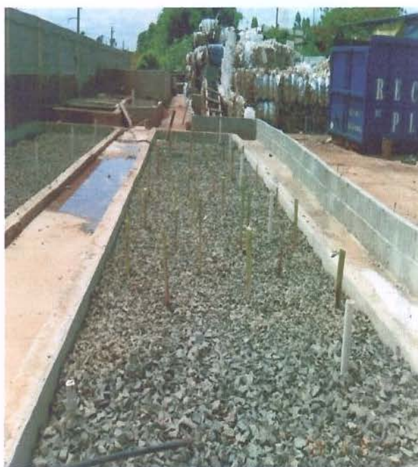
Figura 63 Conclusão da construção e plantio no segundo leito cultivado (09/12/05)
