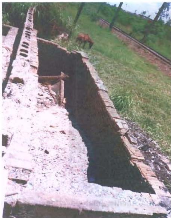
Figura 39 Tanque construído a partir do muro de tras da empresa armazenando resíduos da centrifugação, sedimentação e sobrenadante dos 2 tanques de sedimentação do efluente
