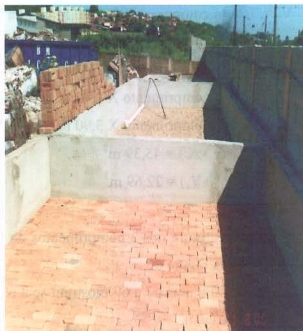
Figura 68 Preenchimento do leito de secagem
