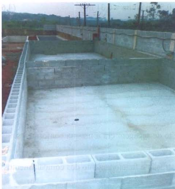
Figura 67 Início da construção do leito de secagem
