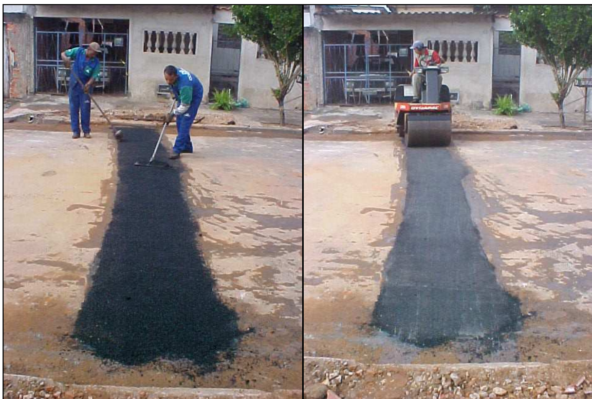
Figura 71. Aplicação da camada final com CBUQ, faixa C do DER SP.
