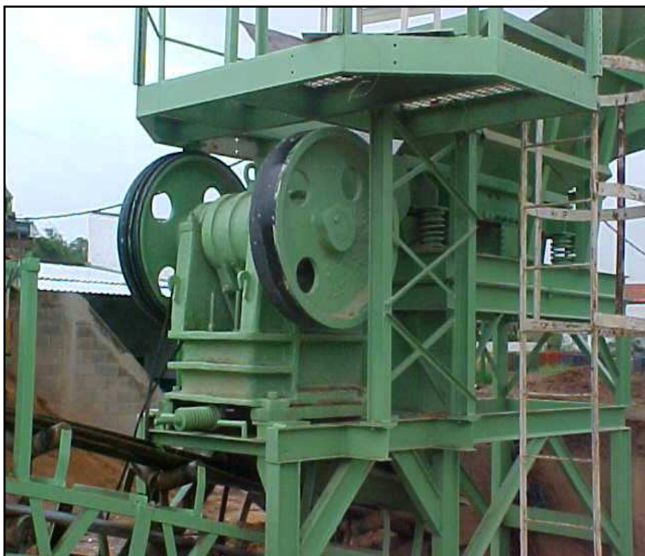
Figura 33C. Câmara de impacto da usina de reciclagem de Vinhedo.
