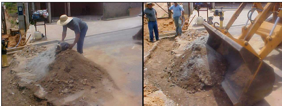
Figura 70. Realização da camada de base de bica corrida com seis por cento de cimento em massa.
