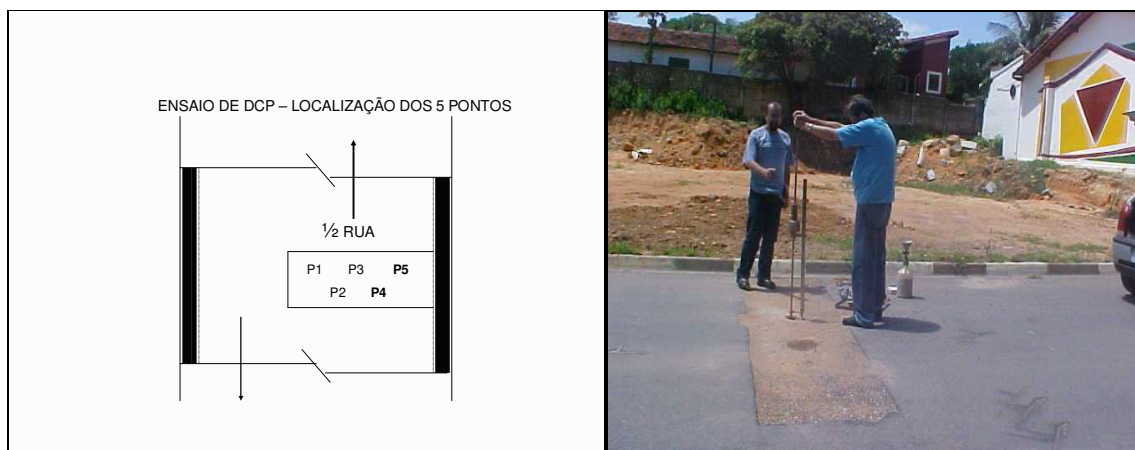
Figura 61. Localização do ensaio de DCP, na primeira intervenção.
