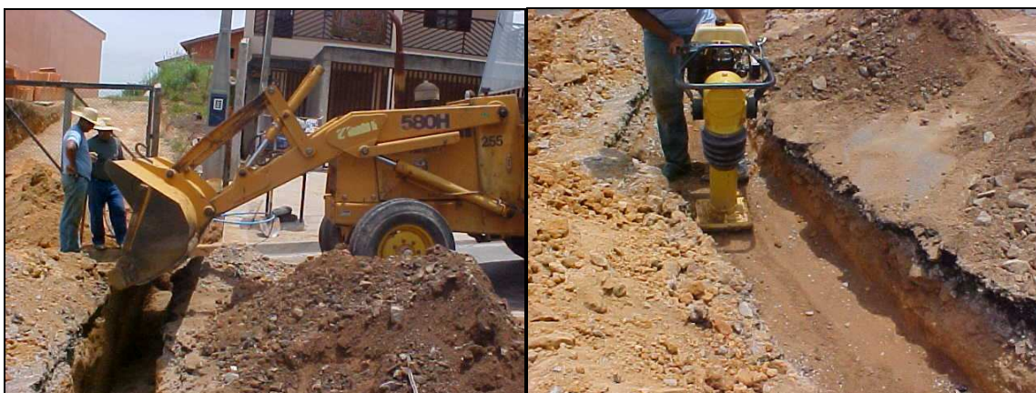
Figura 69. Fechamento da vala em camadas de 20 cm com bica corrida.
