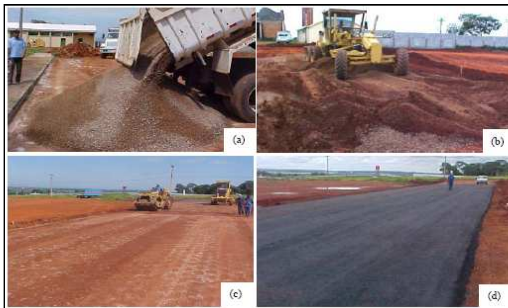
Figura 48. Execução do trecho experimental: (a) deposição do material na pista; (b) espalhamento; (c) compactação; (d) execução do revestimento, LEIVE et al., (2005). p. 40.
