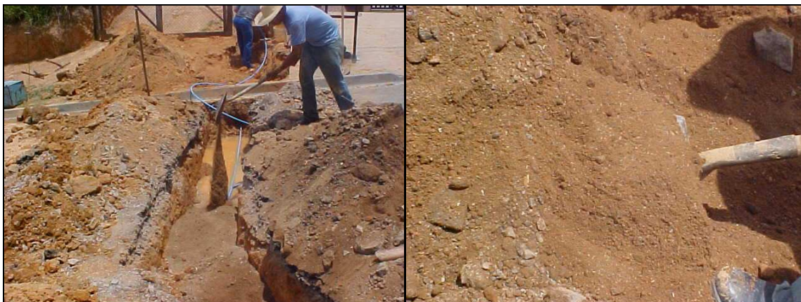
Figura 68. Fechamento da vala após substituição da tubulação que fornece água.
