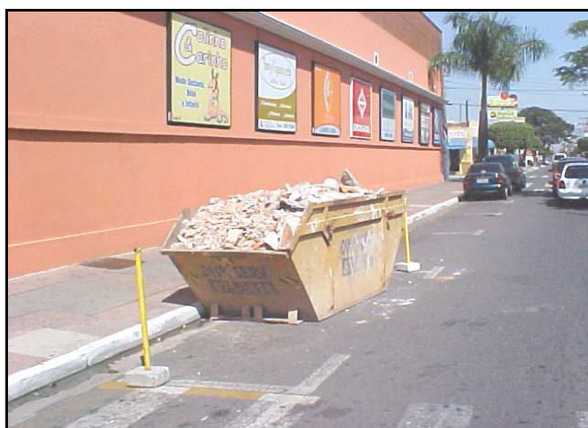
Figura 50. Caçambas metálicas para recolher os resíduos de construção.
