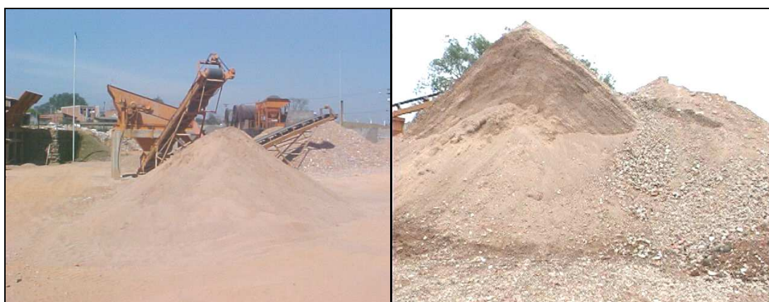
Figura 55. Detalhe do sistema de peneiras, bica corrida e areia do RCD.
