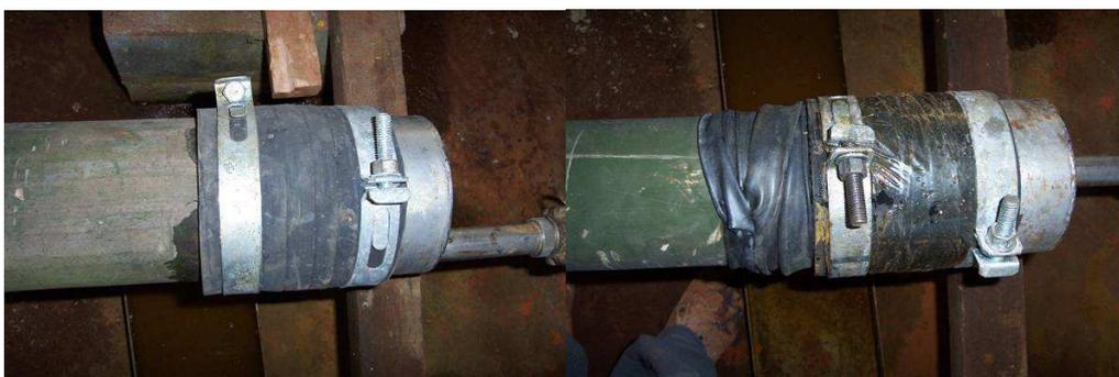
**Figura 17:** Conexão normal e utilizando câmara de pneumático para evitar vazamento.
