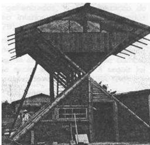
**Figura 2:** Construção de atelier utilizando bambu gigante, Pindorama/SP.
