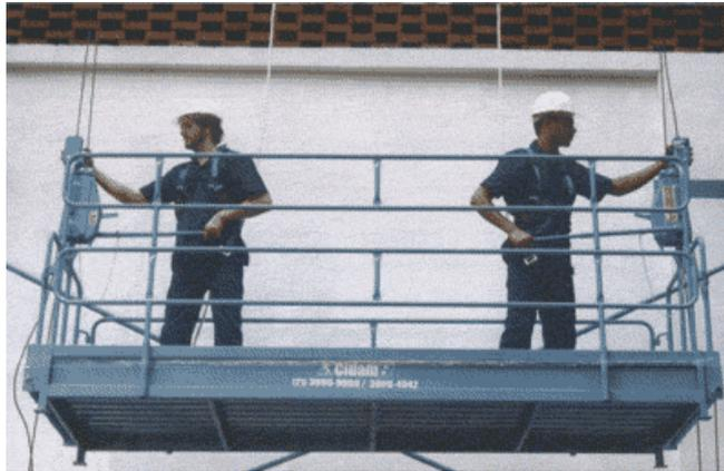
Figura 36 – Trabalhador em um andaime suspenso, riscos de quedas caso não seja utilizado o equipamento de segurança necessário.<sup>6</sup>
