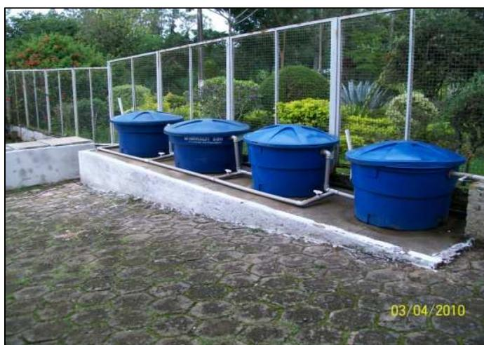
**Figura 4.5:** Caixas de gordura/Tanques de equalização
