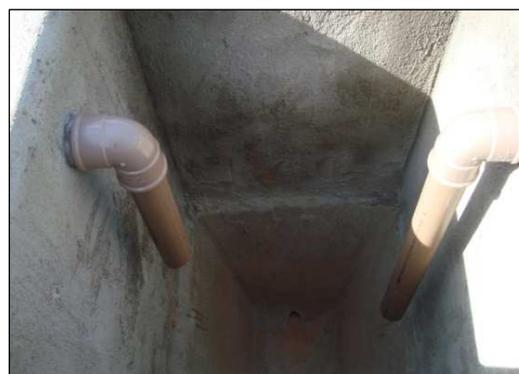
**Figura 4.8:** Detalhe do Sistema de entrada e saída de efluente nas câmaras.
