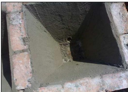
**Figura 4.7:** Detalhe da construção do RAC.
