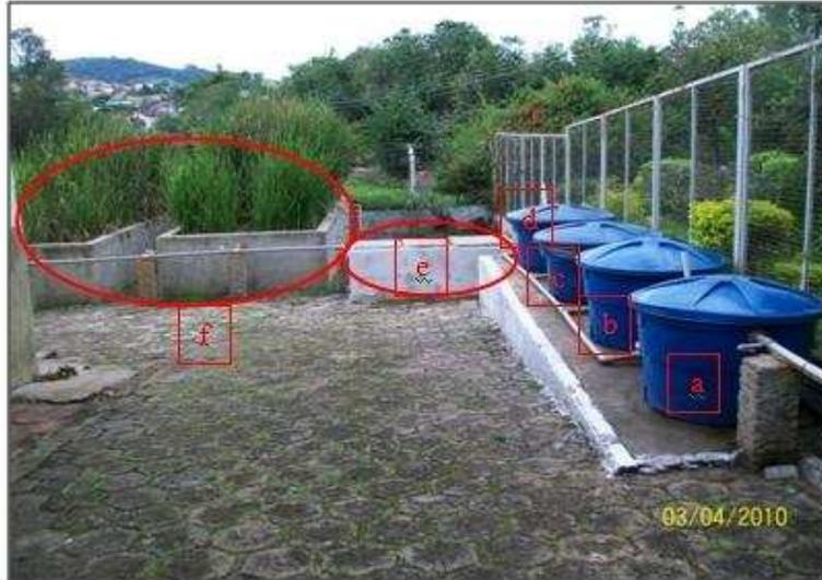
**Figura 4.3:** Sistema de Tratamento – vista geral, a, b,c e d (caixas de gordura), e (reator anaeróbio compartimentado) e f (leitos cultivados com macrófitas).
