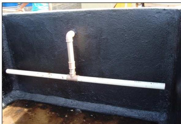
**Figura 4.16:** Dispositivo de entrada do efluente no leito cultivado.
