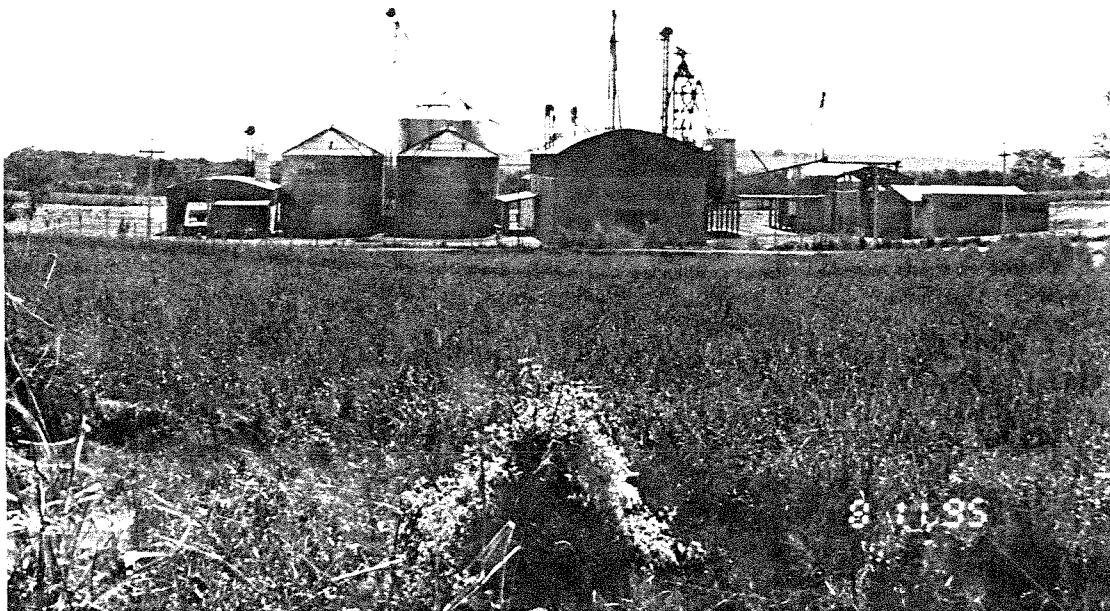
FOTO 1 - Conjunto de silos com várias células
