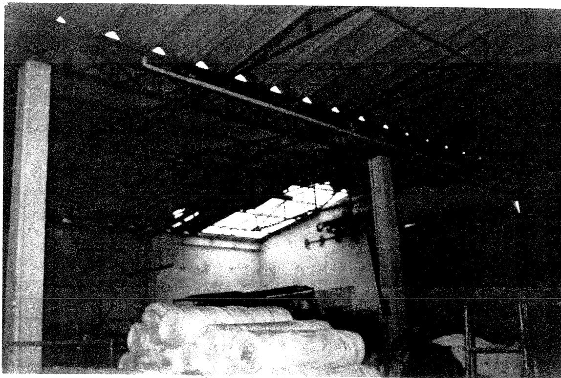
FOTO 9 – Cobertura de construção danificada pela ação do vento.
