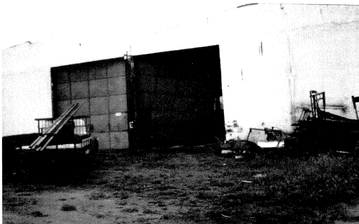
FOTO 10 – Detalhe de portão metálico arrancado de sua posição original pela ação do vento.
