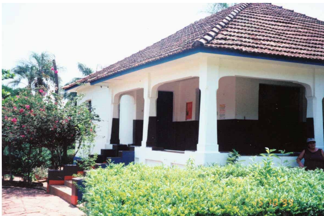
Foto – 14 – Sede do Assentamento reformada (1999).
