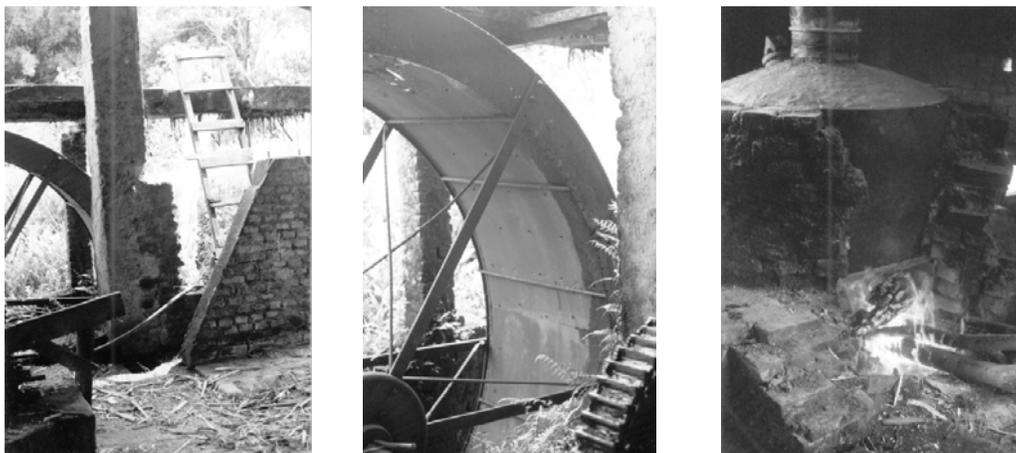
Figura 25 – Alambique movido a roda d'água.(próximo a Capela Santa Cruz da Eva)
