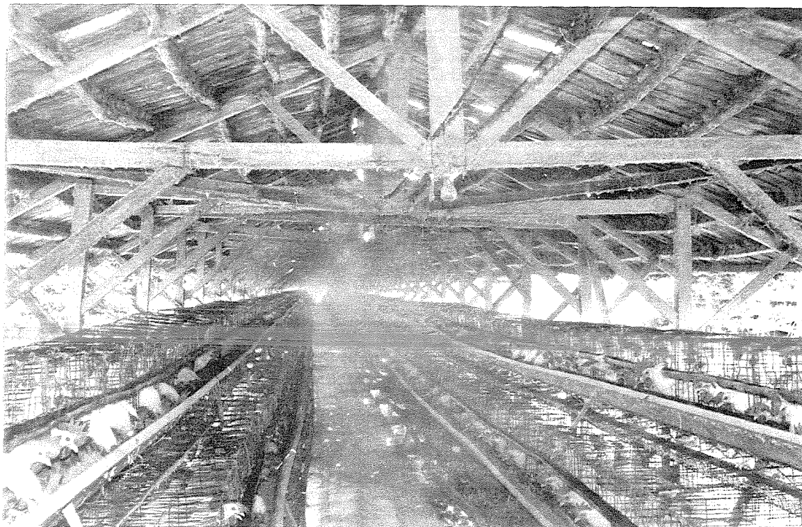
Figura 4.6. Vista parcial do sistema de nebulização em funcionamento no interior do aviário.
