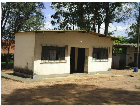
Figura 11. Vista frontal do escritório.
