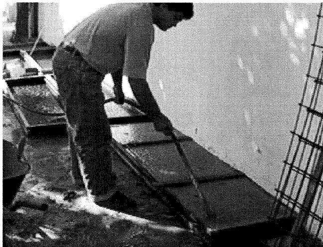
FIGURA 9.13 – Vibração mecânica do concreto
