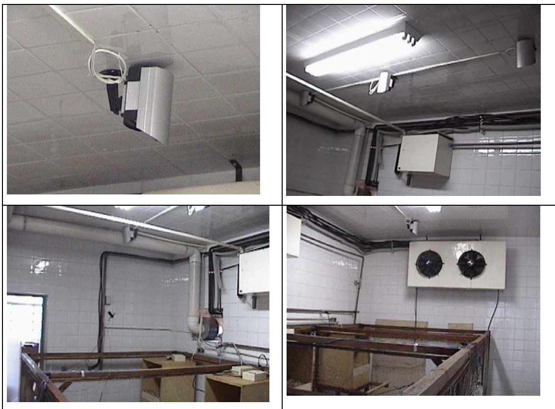
Figura 6. Mini-câmeras de vídeo instaladas no teto, sobre os boxes.
