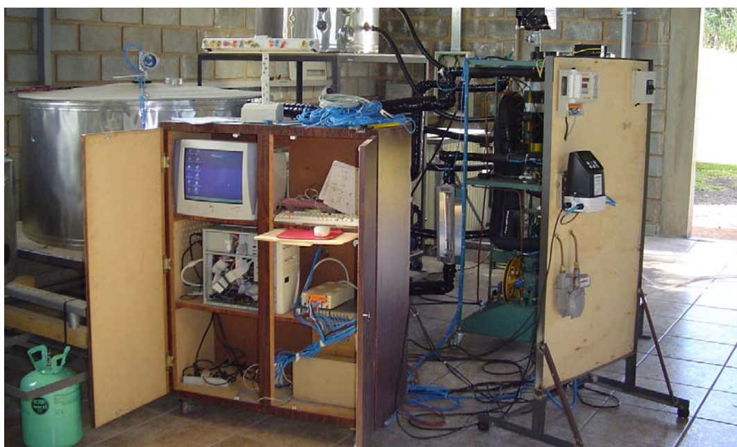
Figura 28. Sistema de aquisição de dados conectado à bomba de calor “B3”
