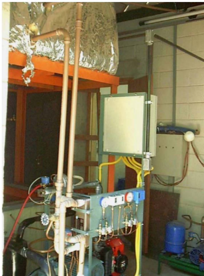
Figura 13. Primeira instalação da Bomba de calor “B1”.
