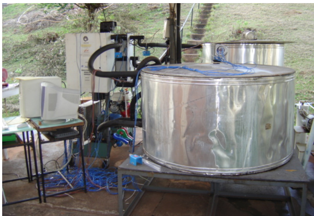
Figura 30. Sistema de aquisição de dados instalado na bomba de calor “B2” durante um ensaio de campo, para medição de dados de temperatura.
