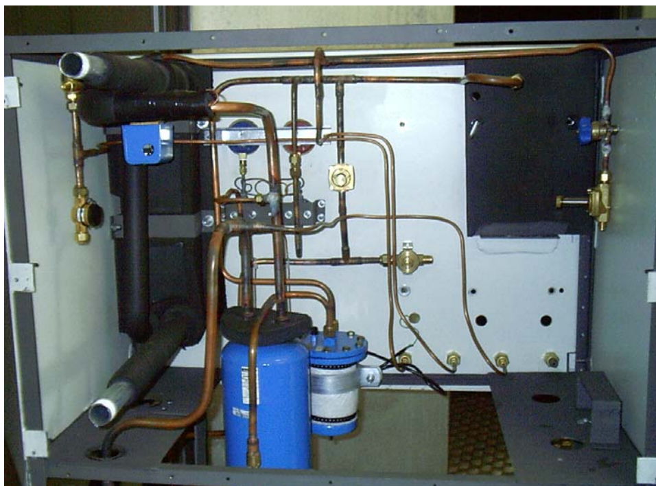
Figura 16. Fase de montagem dos componentes de refrigeração da bomba de calor “B2”.
