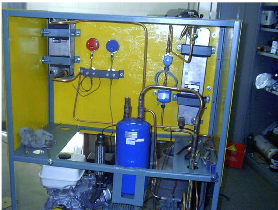
Figura 17. Bomba de calor “B3” na fase de montagem dos componentes de refrigeração.
