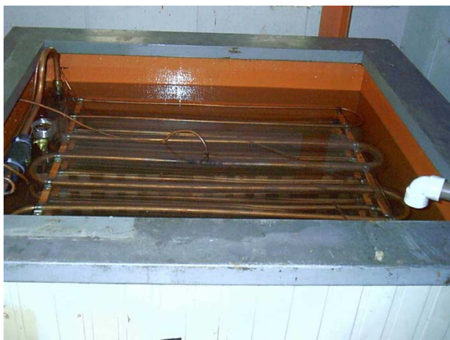
Figura 11. Evaporador instalado no tanque acumulador de gelo da bomba de calor “B1”.
