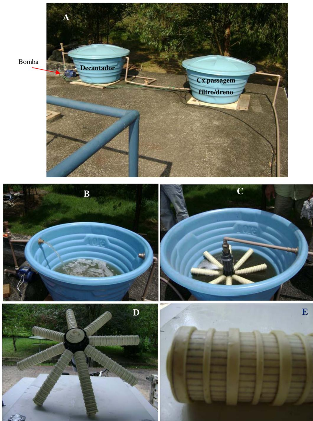
**Figura 11.** (A) interligação do decantador com a caixa de passagem contentora de filtro/dreno, (B) e (C) detalhe das tubulações de entrada e de saída das caixas e disposição do dreno na caixa, (D) e (E) detalhe do dispositivo para reter sólidos na passagem do efluente dentro da segunda caixa.
