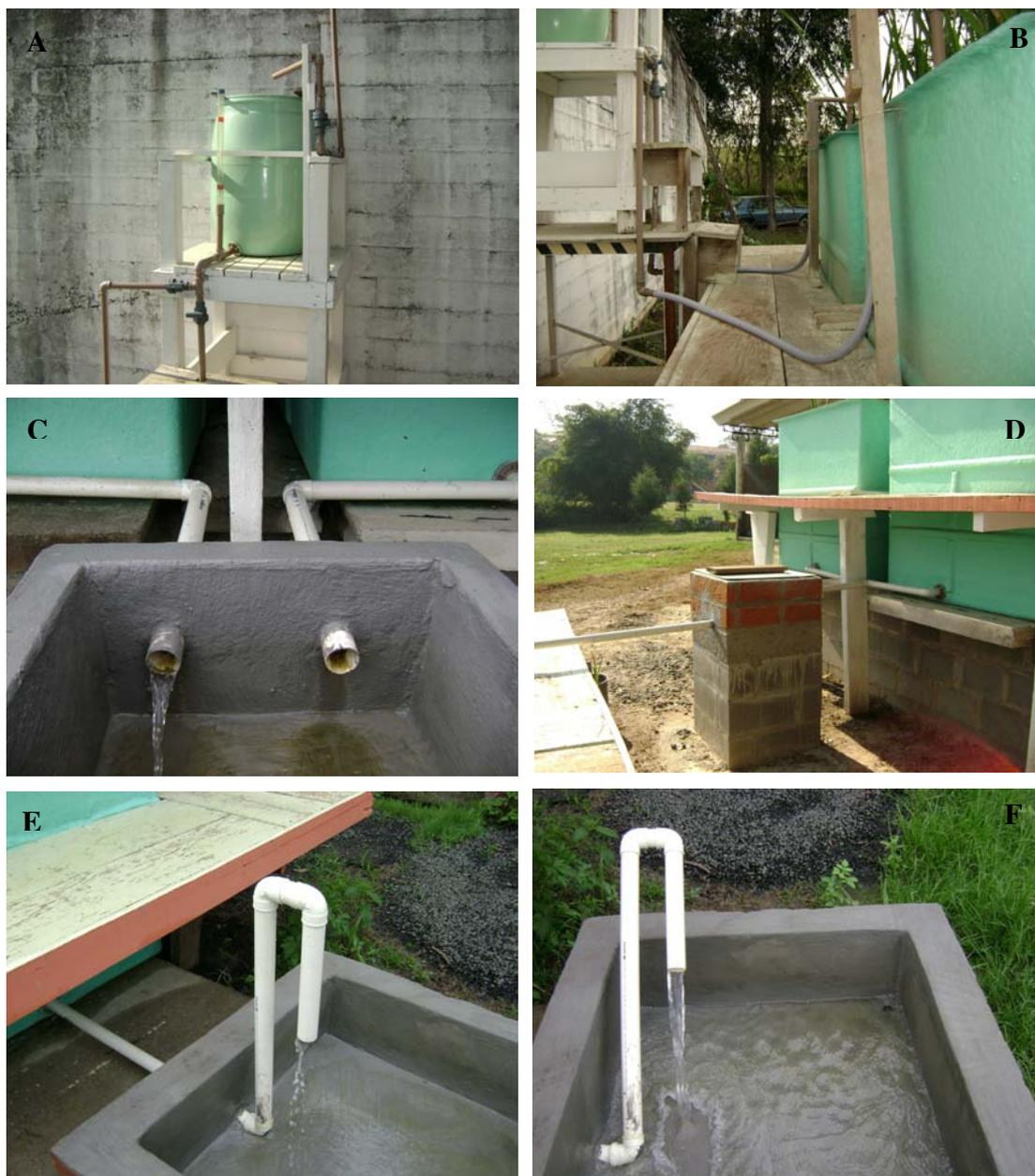
**Figura 13.** Dispositivos para controle e suprimento, entrada e saída de efluente nos leitos: (A) Tonel controlador das aplicações afluentes nos leitos, (B) Tubulação conectada a mangueiras para o suprimento e distribuição na entrada dos leitos de fluxo vertical, (C) e (D) Saídas individuais e caixa de passagem para o efluente advindo dos leitos de fluxo vertical, (E) e (F) Tubo controlador de nível e de saída do efluente do leito de fluxo horizontal.
