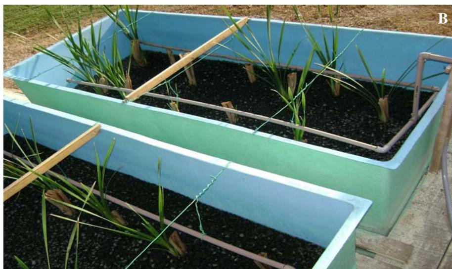
**Figura 19.** Tubulação de distribuição nos leitos de fluxo vertical suspensa por três linhas de fio.
