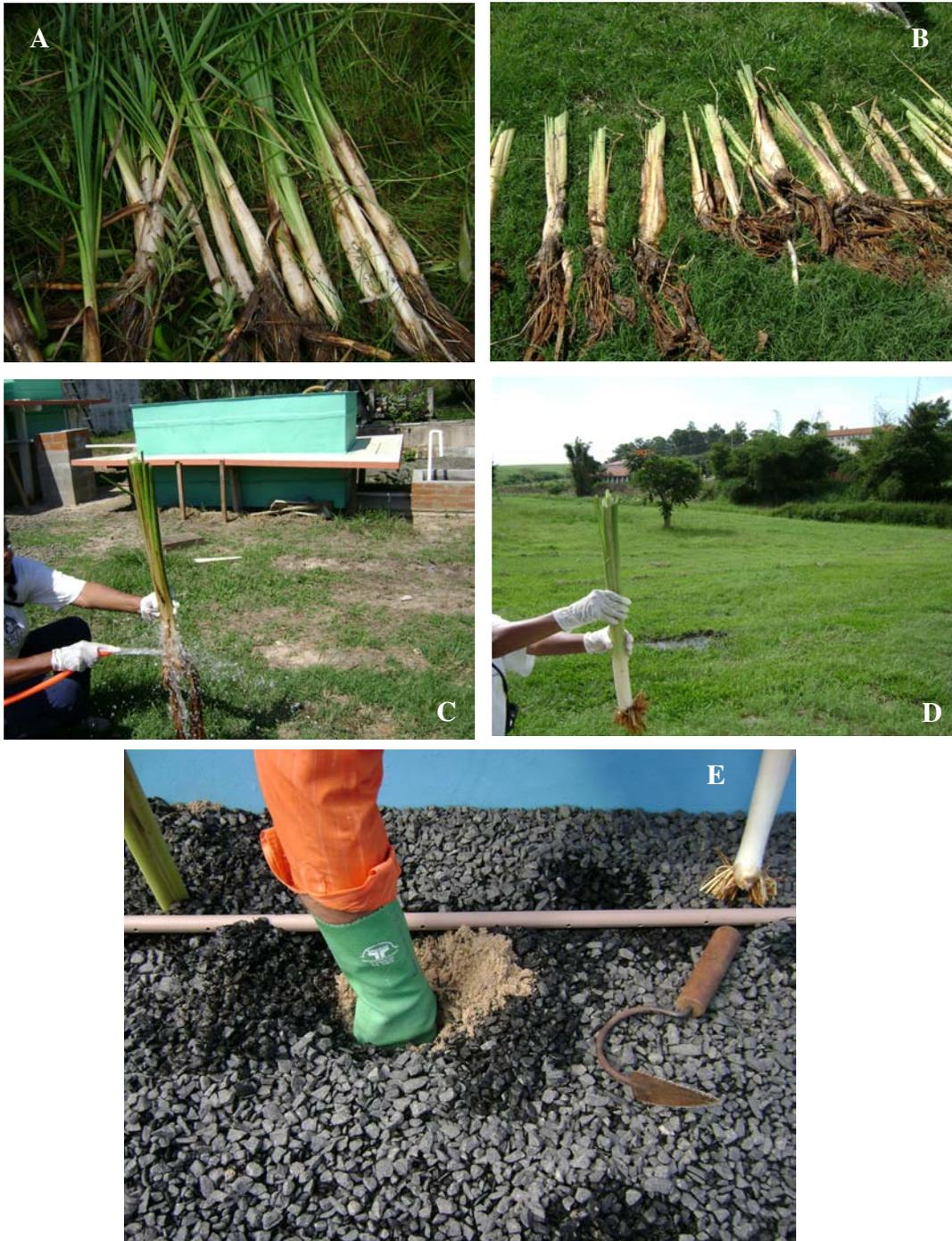
**Figura 24.** Primeiro plantio das macrófitas. (A) e (B) detalhe da retirada das taboas na área de várzea e cortes pontuais das folhas, (C) e (D) retirada da matéria orgânica das raízes (primeiro plantio), (E) plantio manual da macrófita direto no maciço filtrante sem que houvesse matéria orgânica nas raízes e inundação no maciço filtrante.
