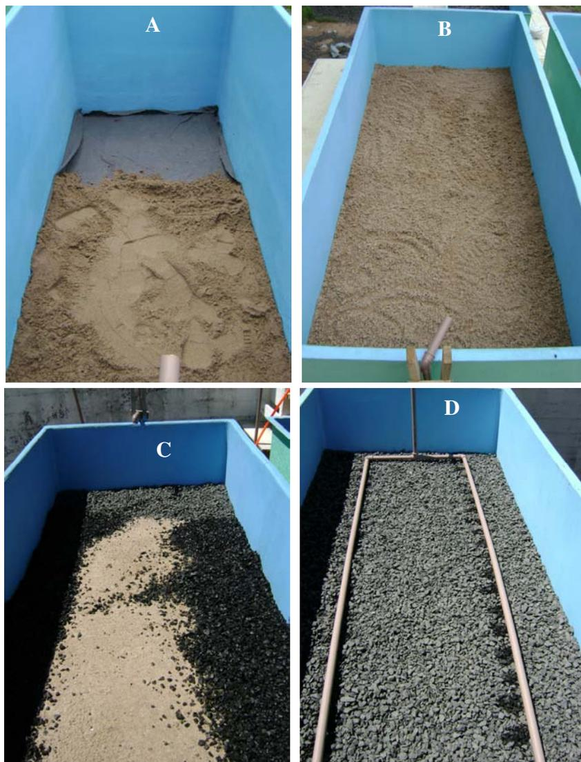
**Figura 18.** Montagem dos leitos cultivados com macrófitas de fluxo vertical: (A), (B) enchimento do filtro com areia grossa; (C), (D) colocação da camada de brita 1 sobre a areia e tubulação de distribuição do efluente.
