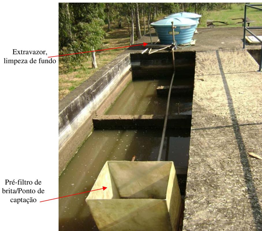
**Figura 9.** Foto demonstrativa da 1ª Etapa do Sistema Experimental: (1) pré-filtro de brita 2 como ponto de captação do efluente e suporte de fibra de vidro para proteção em relação às subidas de nível no tanque de captação; (2) decantador; (3) caixa de passagem contendo filtro/dreno.
