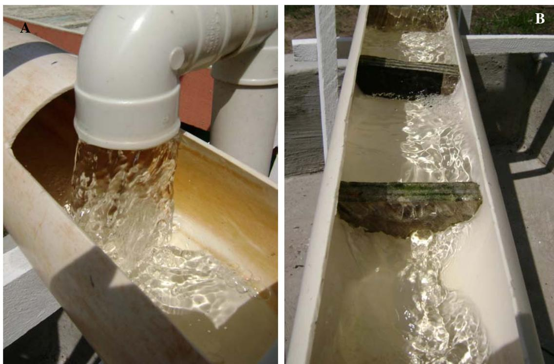
**Figura 36.** Efluente clarificado: (A) na saída do Leito de Fluxo Horizontal; (B) no canal de cloração.
