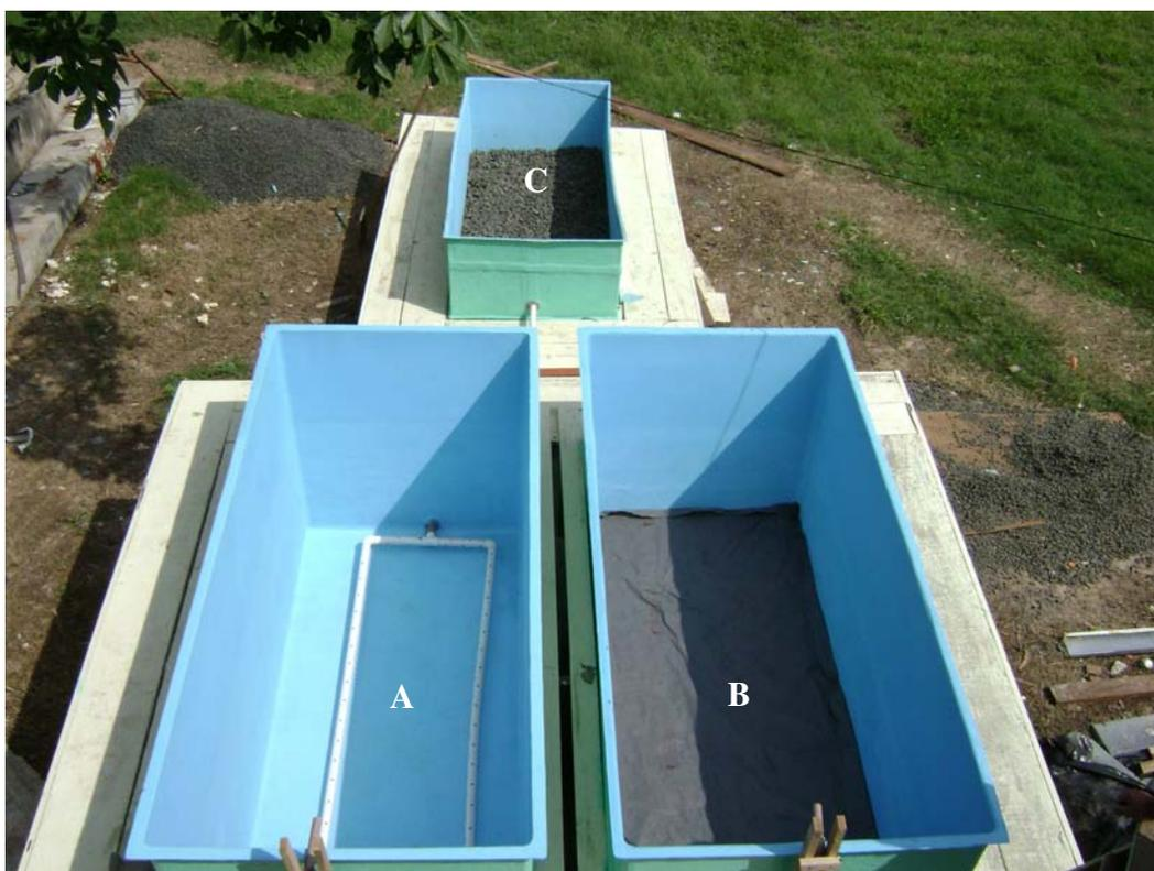
**Figura 15.** Disposição dos leitos e a montagem do maciço filtrante. (A) tubulação de coleta do efluente no leito vertical, (B) manta de bidim sobre a camada de fundo de brita 1, (C) leito de fluxo horizontal preenchido com brita 2.
