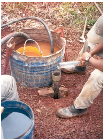
Figura 30. Preenchimento do furo de sondagem revestido, com água.
