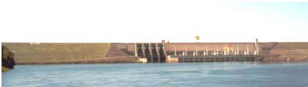
Figura 4. Proteção do talude de jusante da UHE de Ilha Solteira/CESP utilizando gramíneas.
