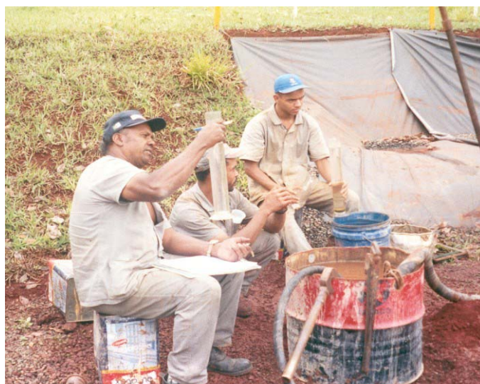
Figura 31. Verificação do volume de água percolado.
