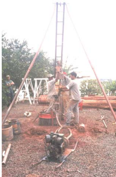
Figura 33. Execução da sondagem SP01.
