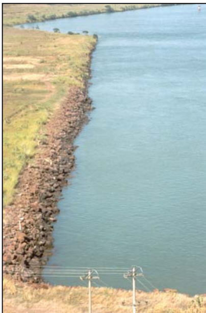
Figura 3. Proteção da margem à jusante da barragem da UHE de Ilha Solteira/CESP.
