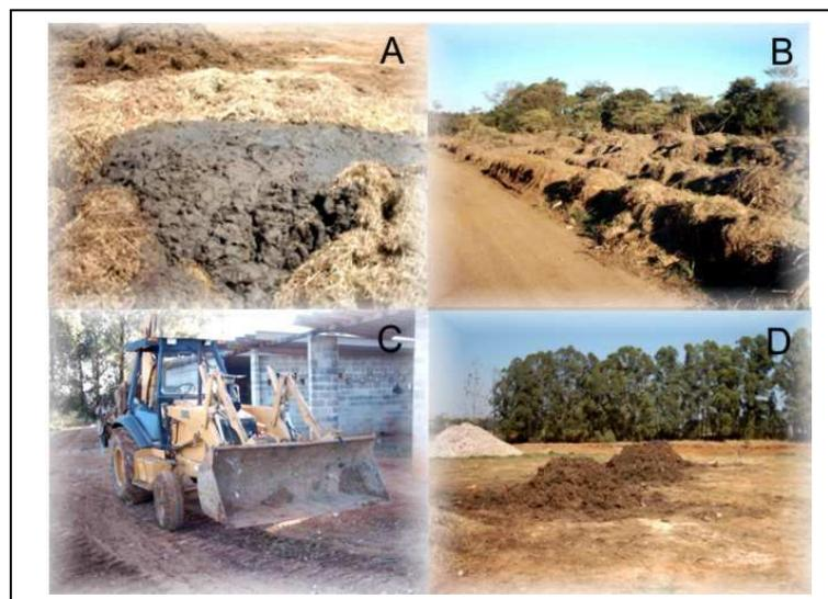
**Figura 7 – Detalhe da mistura de lodo de esgoto com o resíduo estruturante (A), área de armazenamento de resíduos de roçagens (B), pá-carregadeira utilizada para revolvimento das leiras de compostagem (C) e leiras de compostagem no aterro municipal de Mogi Guaçu– SP em agosto de 2004 (D)**
