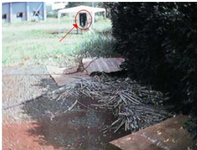
**Figura 15** – Caixa de areia de armazenamento da água pré-tratada pelo sistema de leitos cultivados, que é utilizada no filtro de areia destacado ao fundo.
