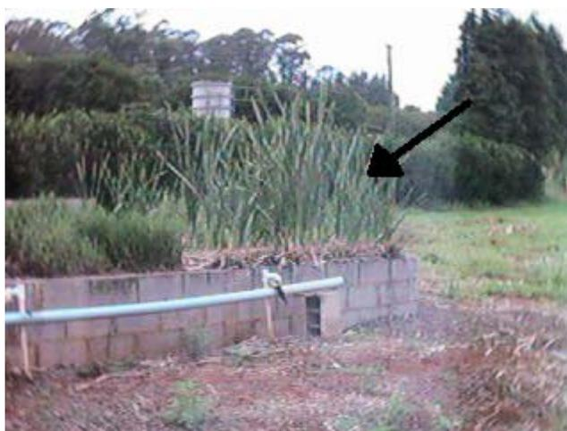
**Figura 14** – Vista parcial dos leitos cultivados com tipos distintos de macrófitas. Em destaque do leito quadrado (2x2m) com typha.
