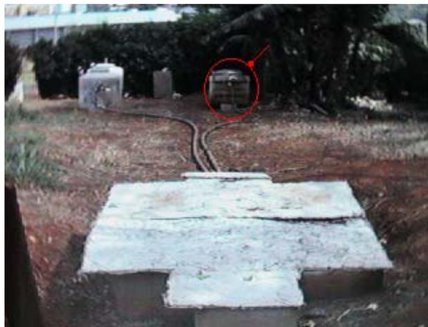
**Figura 9** – Vista da caixa de areia onde é captado o esgoto da FEAGRI para tratamento. Ao fundo em destaque o tanque séptico modificado.
