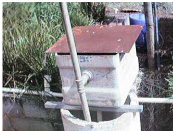
**Figura 11** – Vista da caixa de distribuição de vazão.
