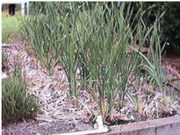
**Figura 13** – Vista parcial dos leitos cultivados com macrófitas. Leito retangular (4x1m). Pode-se verificar a existência do material de suporte brita n.º 2 juntamente da linha em PVC que deposita afluente dentro do leito.
