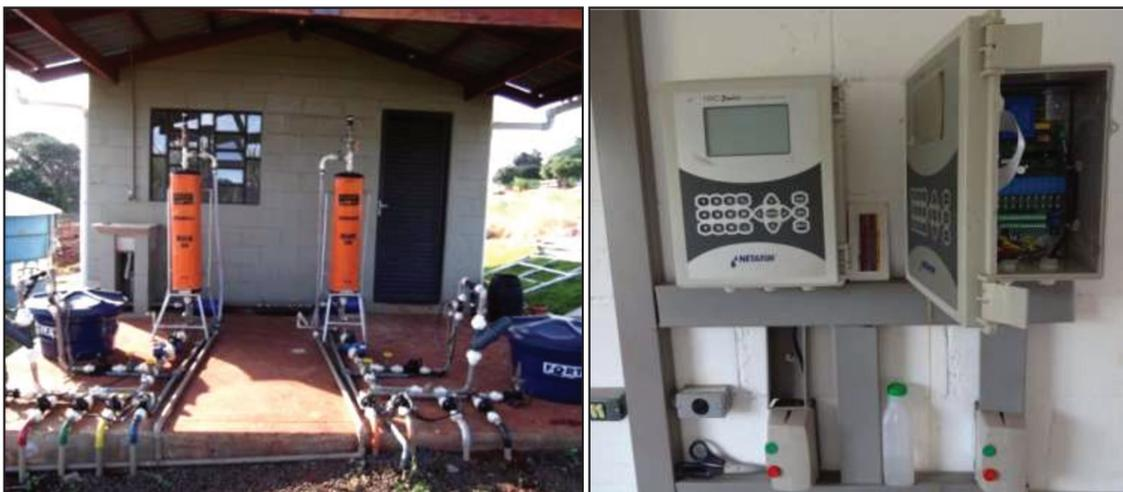
**Figura 29** - Sistema de filtragem, válvulas de controle e fertirrigação (esquerda) e painéis de controle do sistema de irrigação (direita).
