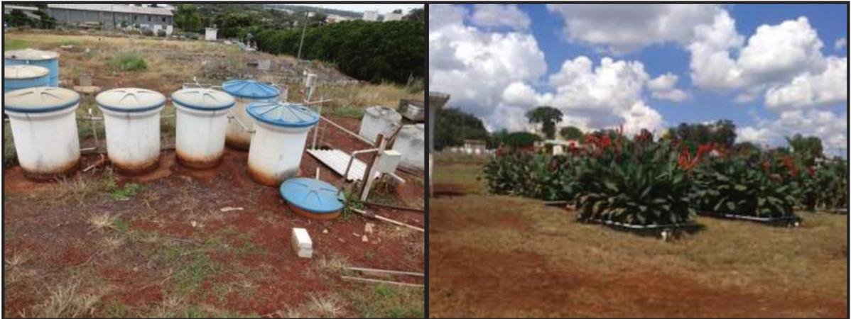
**Figura 27** - Sistema de tratamento de esgoto. Reatores anaeróbicos e tanque cultivado com macrófita.
