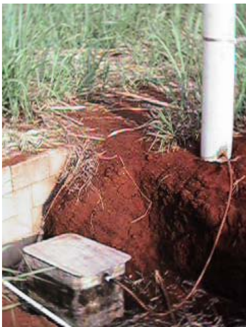
FIGURA 5 – Caixa de água pertencente ao sistema de evapotranspirômetro
