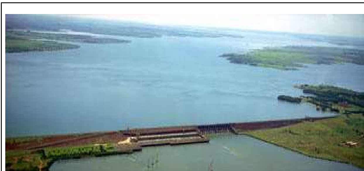
Figura 13 Vista da Usina Hidrelétrica de Ilha Solteira (CESP, 1988)
