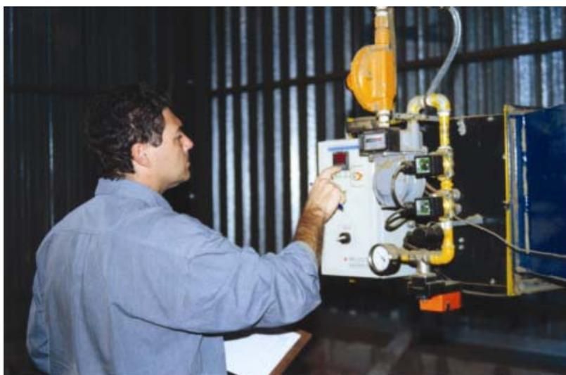
Figura 4.19- Registrador de consumo acoplado ao queimador.
