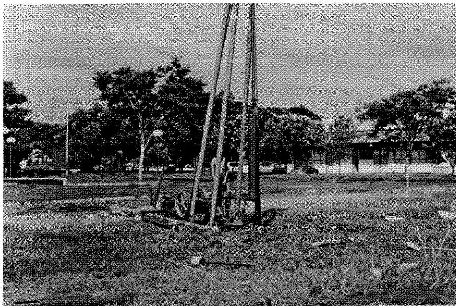
Figura 4. Equipamento utilizado na abertura dos furos das estacas
