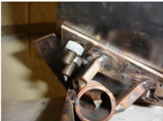
Figura 43 - Soldagem das peças de barra chata 3/4"(19mm) x 3/16"(4,7mm) entre a chapa( de 95mm x 45mm) e o tubo de \phi e=26,7mm(comp.=30mm)
