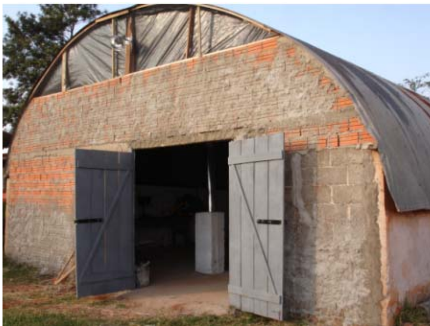
Figura 48 – Local de instalação da fábrica
