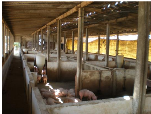
Figura 8. Abertura na cumeeira do telhado.
