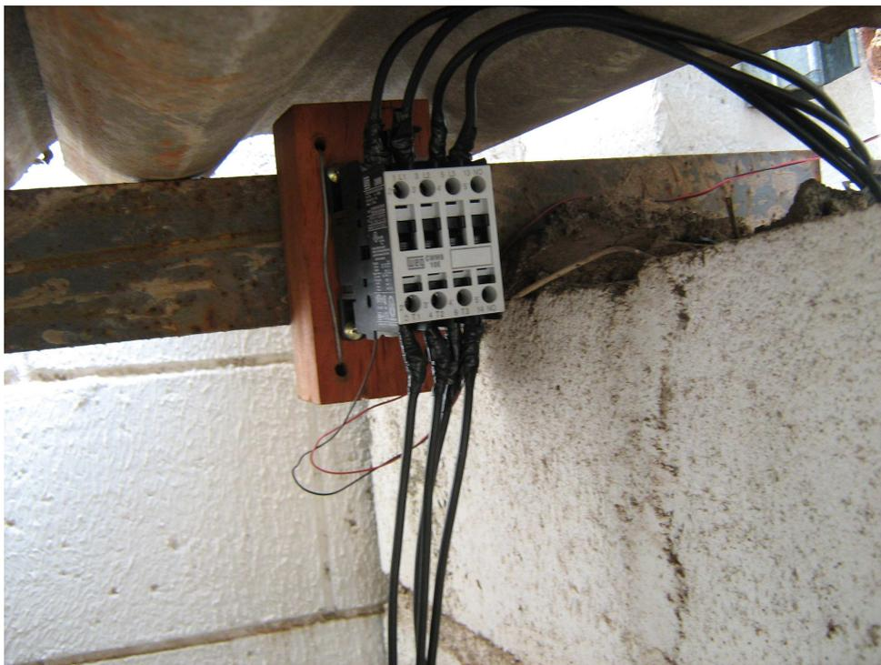
**Figura A.14:** Chave contatora para acionamento da bomba centrífuga externa de propileno glicol.
