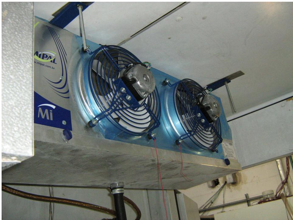
**Figura A.8:** Vista interna da câmara frigorífica de estocagem, mostrando parte frontal do trocador de calor aletado para o fluido secundário.
