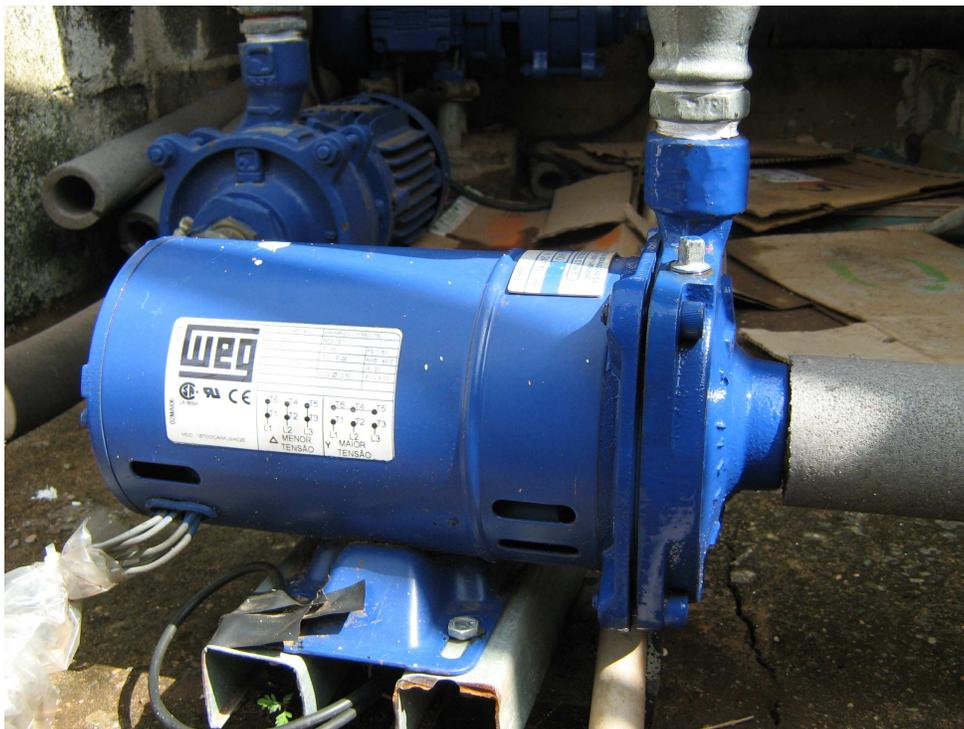
**Figura A.6:** Bomba centrífuga externa localizada próxima ao tanque.
