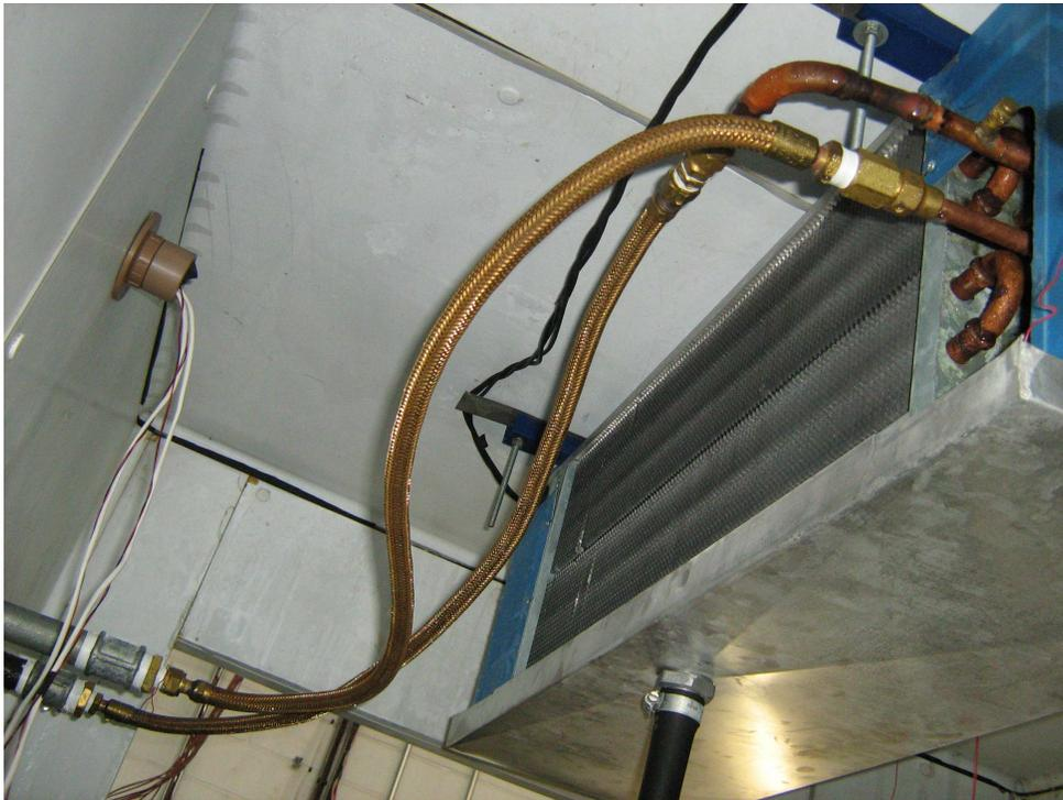
**Figura A.9:** Vista interna da câmara frigorífica de estocagem, mostrando parte traseira do trocador de calor aletado para o fluido secundário e tubulação flexível de latão.
