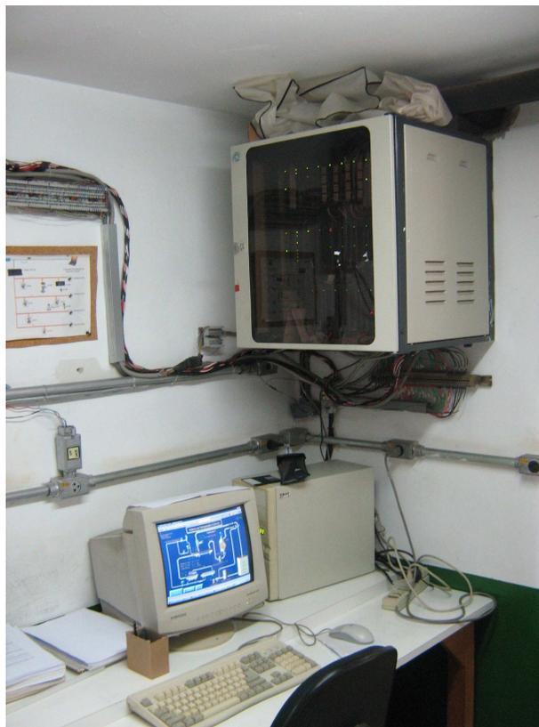
**Figura A.12:** *Rack* com os *slots* e o CLP, integrados ao computador.
