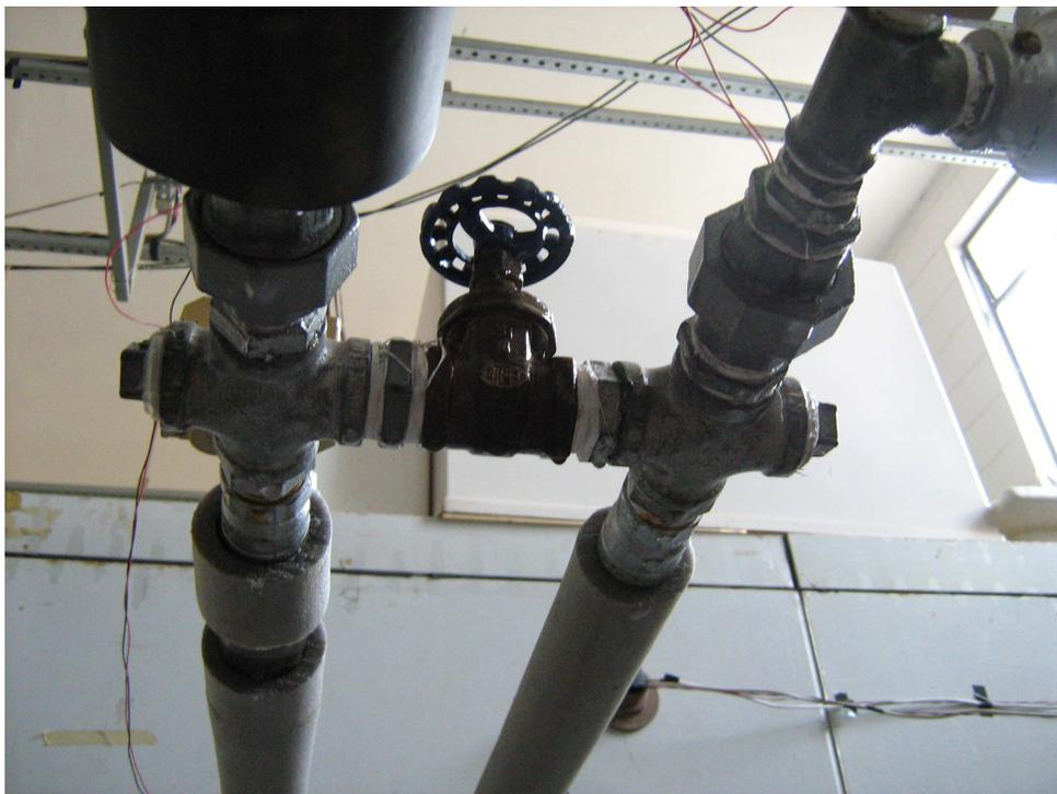
**Figura A.10:** Passagem secundária para o fluido (*bypass*), localizada próxima à câmara.
