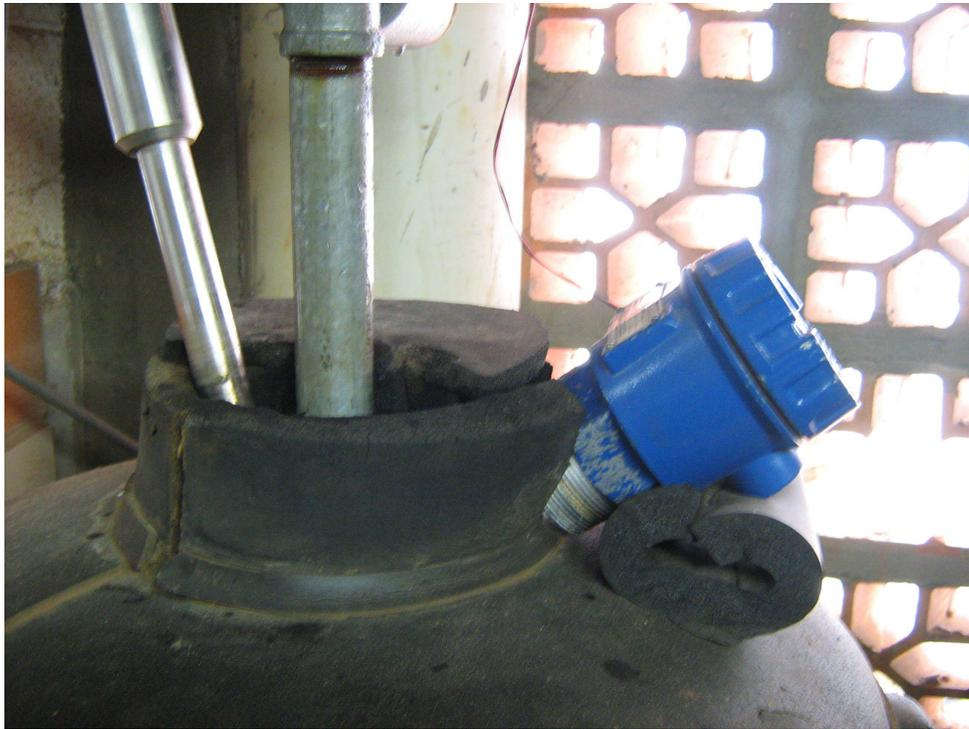
**Figura A.13:** Chave de nível tipo boia instalada no tanque pulmão de propileno glicol.
