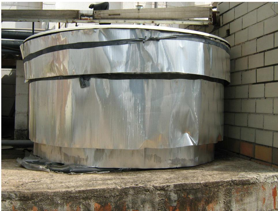
**Figura A.4:** Reservatório termoacumulador de propileno glicol.
