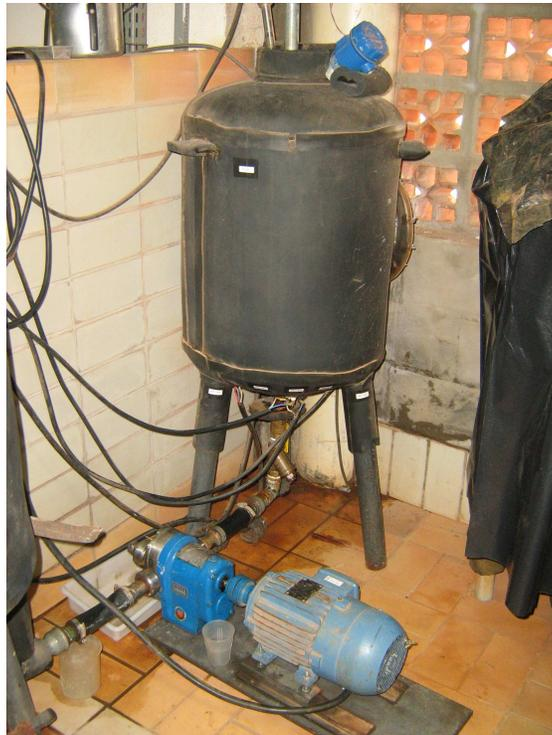
**Figura A.7:** Tanque pulmão de propileno glicol e bomba de lóbulos e deslocamento positivo.
