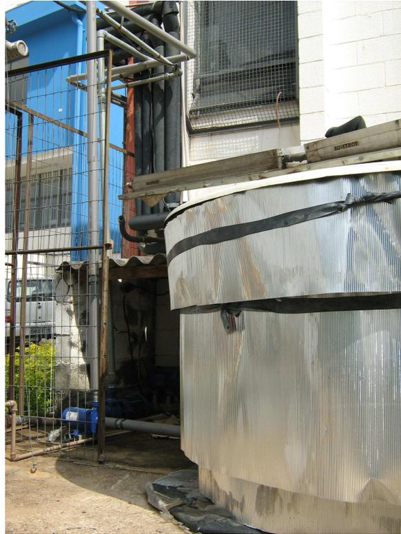
**Figura A.5:** Reservatório termoacumulador de propileno, bomba centrífuga externa e parte da tubulação isolada.
